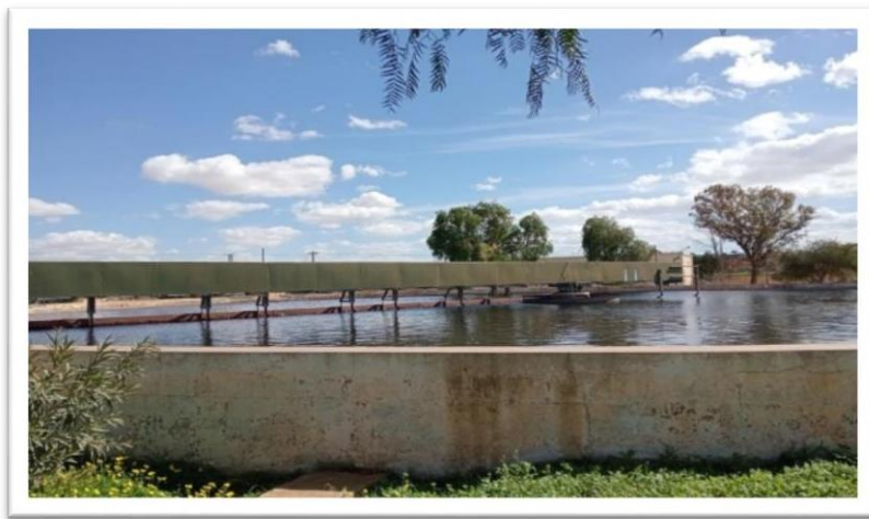
Photo. IV.8: Décanteurs secondaires
