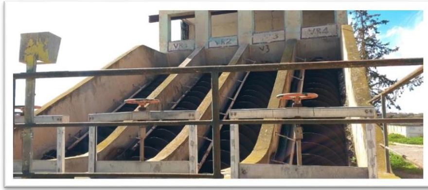
Photo. IV.3: Bâtiment de relevage.
