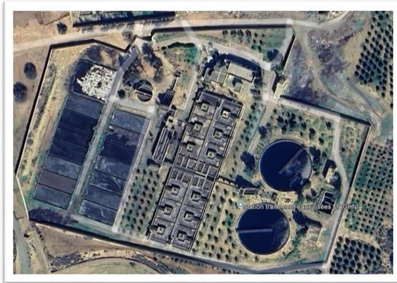
Fig. IV.9 : Vue de la station d'épuration de Maghnia (Google Earth)
