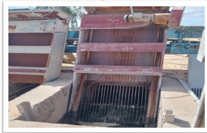
Photo. IV.4: Grilles mécaniques.
