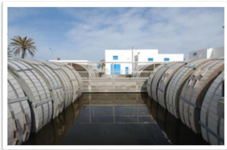
Fig. II.7 : Disque biologique (Toubal, M.,2024).
