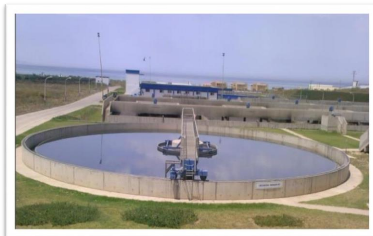
Fig. II.3 : Décanteur primaire (Toubal, M.,2024)
