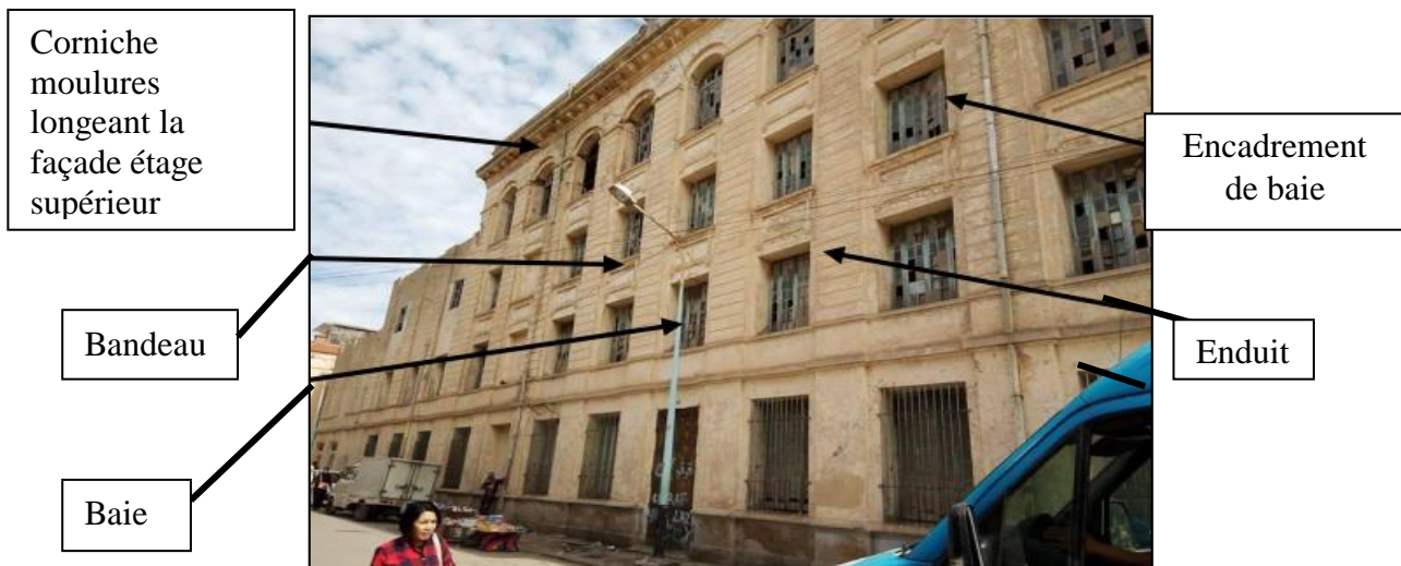
Figure 41: les éléments de la façade de la minoterie Source : Auteurs
