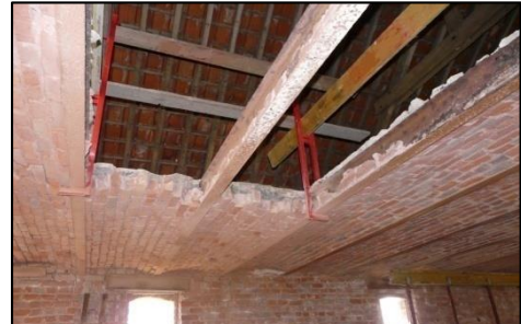
Figure 46: Ouverture d'une trémie d'escalier dans un plancher en
