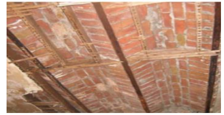
Figure 45 : Plancher en voutain
