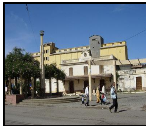
Figure 33: la gare ancienne Source : auteurs
