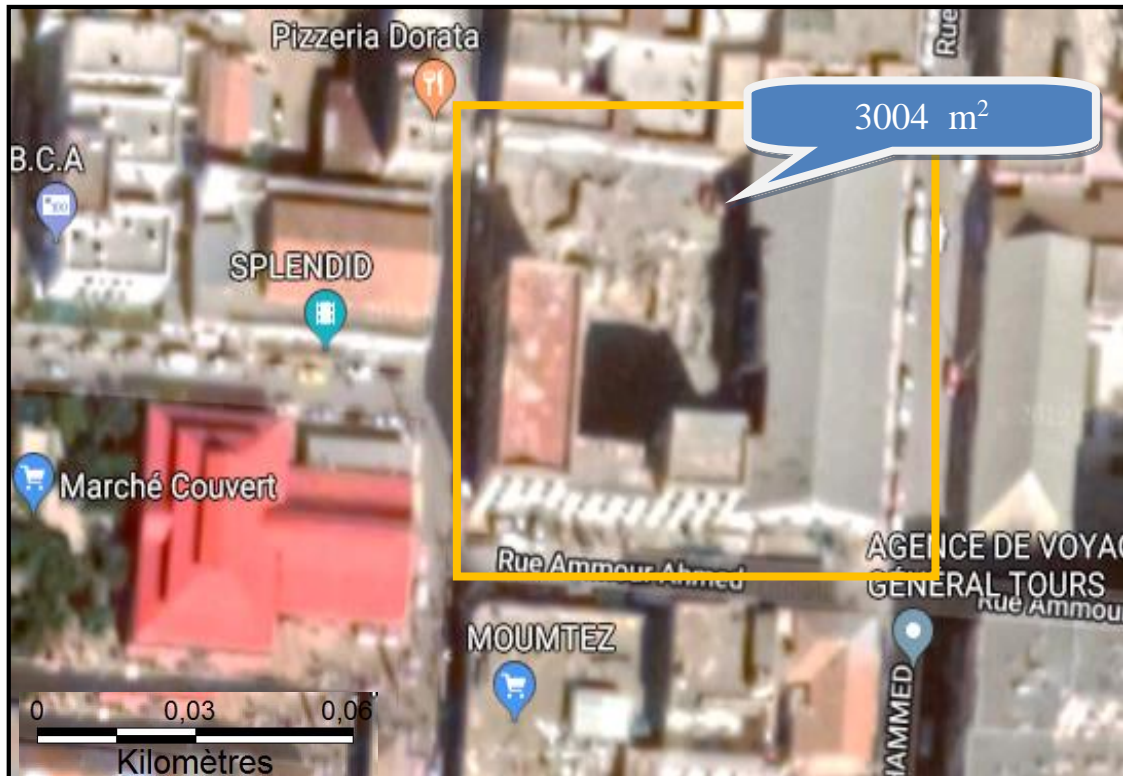
Figure 34 :vue aerienne surla minoterie de «Baret »
