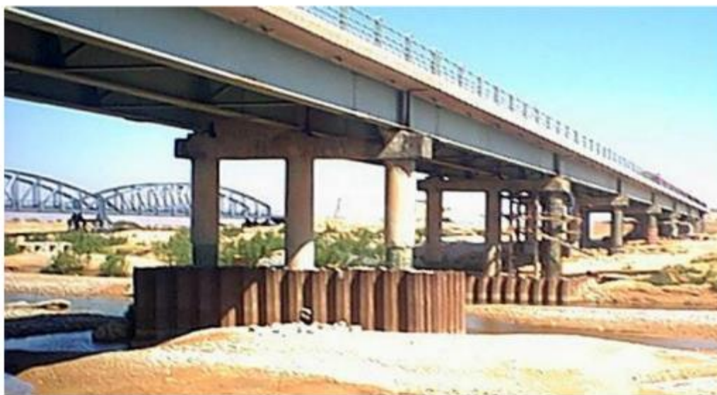
Figure I-3 : Vue générale du pont (Guettala, 2002).
