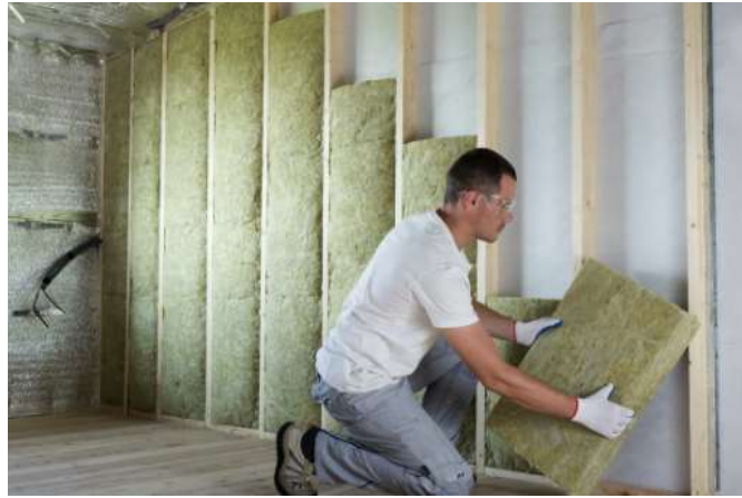
Figure II. 1 : Isolation d'un mur par l'intérieure. [36]
