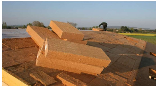
Figure II. 28 : Pose de panneaux de fibres de bois semi-rigides sur une charpente bois.
