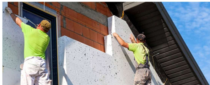
Figure I. 18 : Isolation thermique par l'extérieur. . [25]
