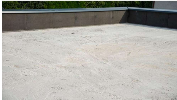
Figure II 24 : Mise en œuvre d'un béton léger isolant pour une toiture-terrasse isolation et forme de pente. . [56]
