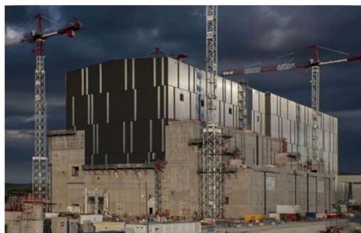
Figure II. 26 : Béton lourd comme barrière structurelle et thermique. . [60]
