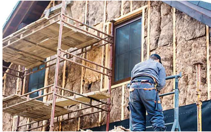
Figure II. 2 : Isolation d'un mur par l'extérieure. [37]
