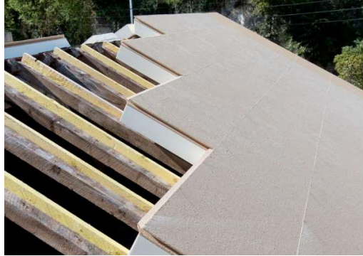
Figure II. 7 : Isolation de toiture par l'extérieure.
