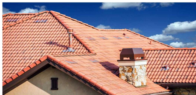
Figure I. 20: Toiture en tuiles. [30]
