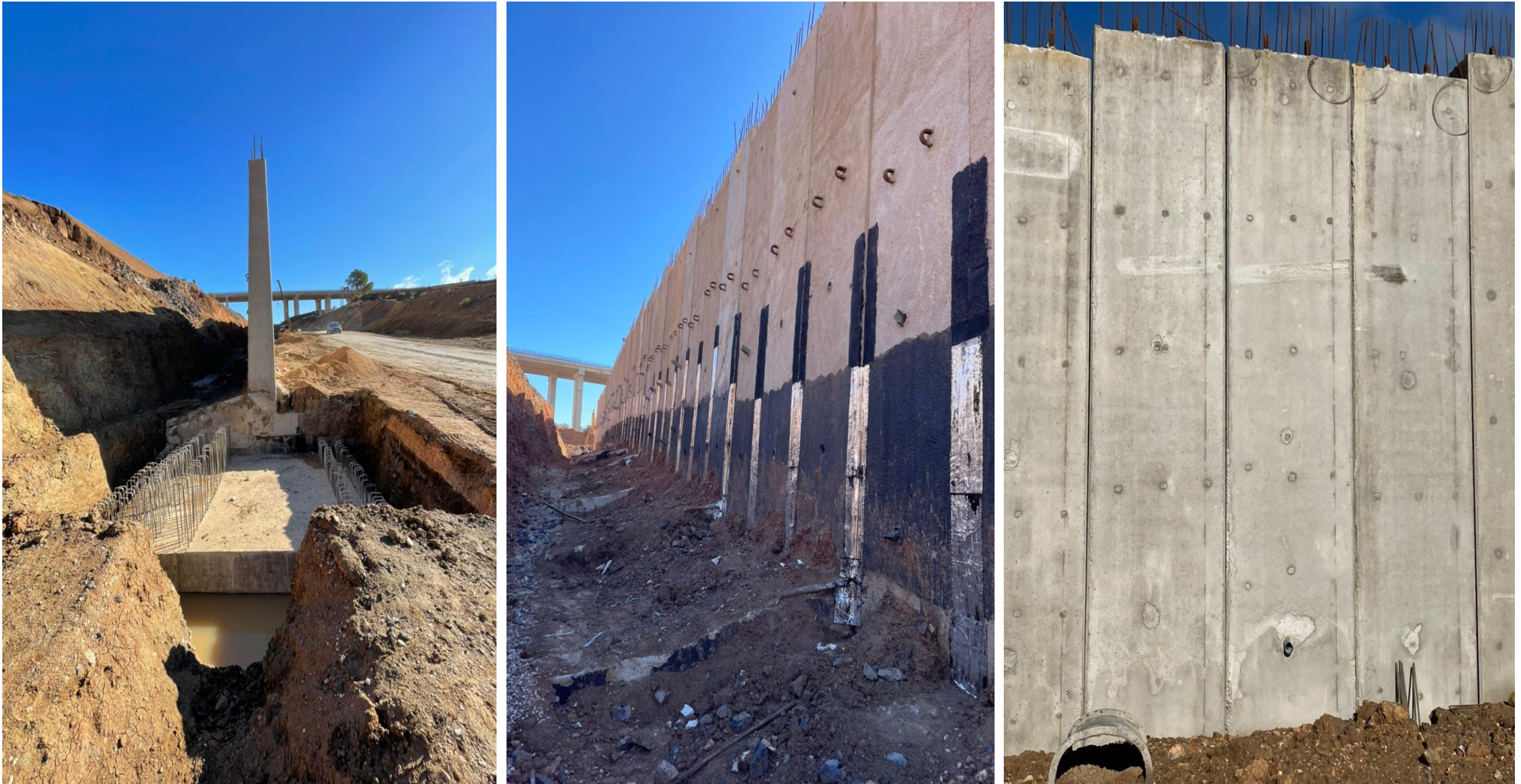
Figure 3.3 : Photos de l'ouvrage Prise par Bentalha & Medjahdi le 3 février 2025
