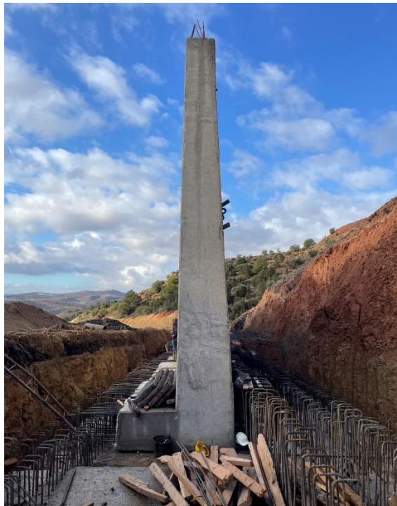
Figure 01.4 : Photo d'un mur de soutènement à Ghazaouet
