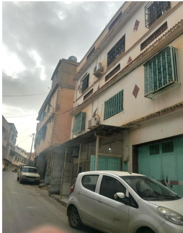
Figure 38: Des façades peintes dans le quartier de Boudghène.
