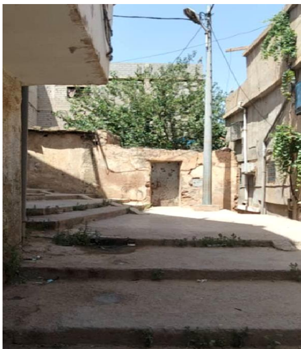
Figure 20: Habitation délabrée non habitée dans une zone piétonne.
