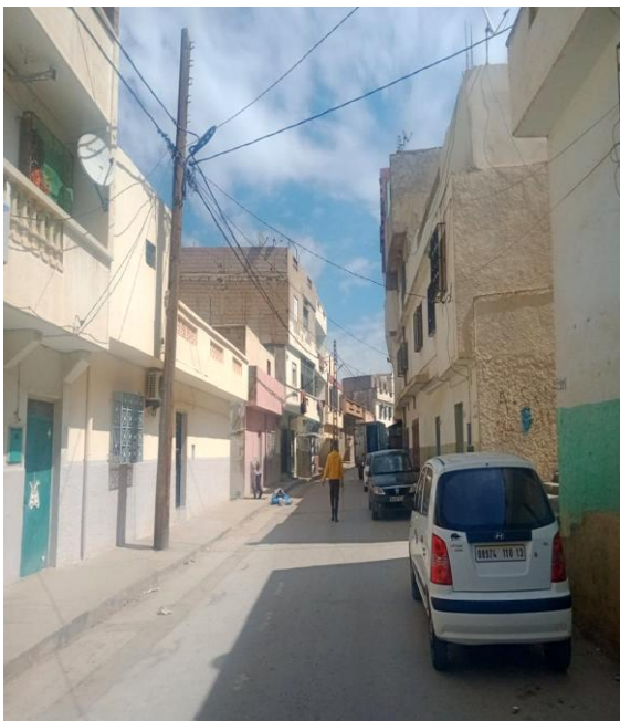
Figure 16: Habitations en moyen état dans une voie secondaire.
