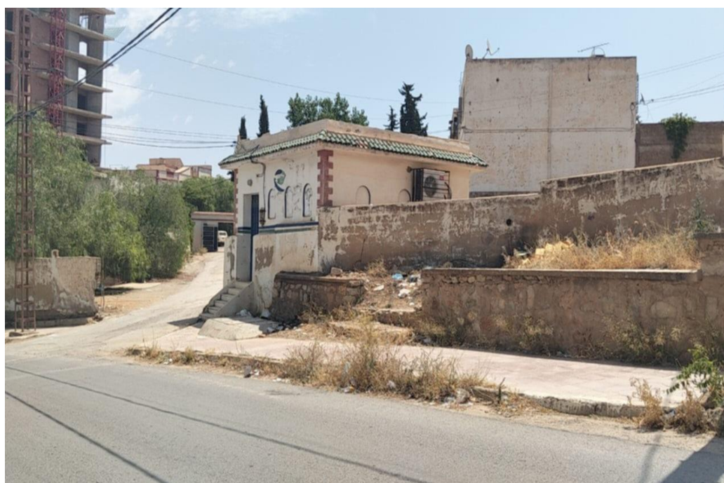
Figure 52: Local technique d'Algérie Télécom (poste de distribution Internet et téléphonie) dans le quartier de Boudghène.
