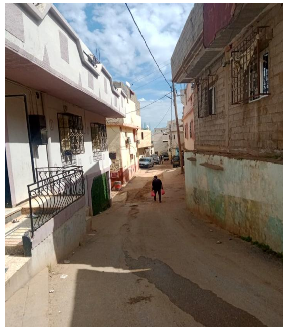
Figure 17: Habitations en moyen état dans une autre voie secondaire.
