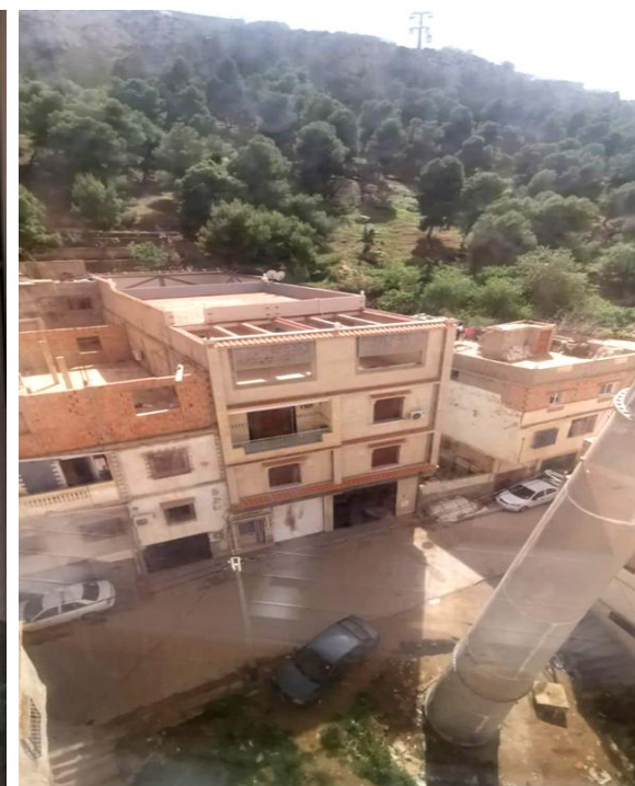
Figure 42: Vue générale des façades se trouvant dans la limite Sud du quartier (photo prise depuis le téléphérique)
