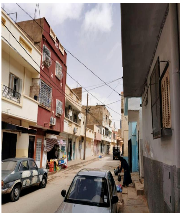
Figure 41: Vue générale des façades se trouvant dans l'une des voies secondaires de Boudghène.
