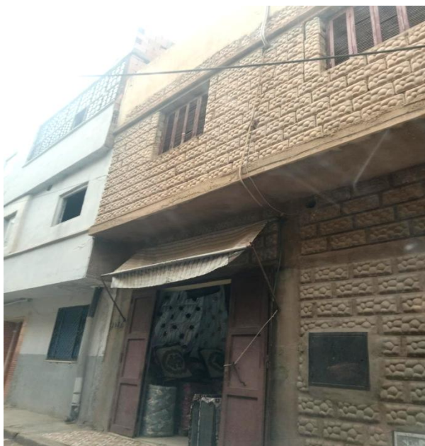
Figure 39: Façade en revêtement de faux-pierre à Boudghène.
