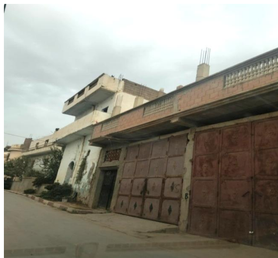
Figure 36: Construction inachevée en RDC.
