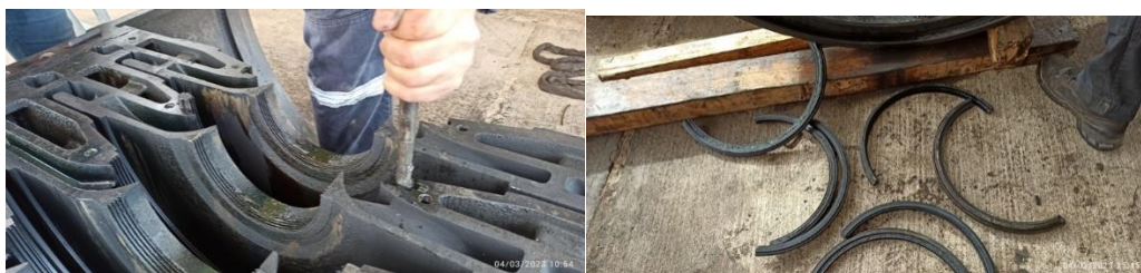
-Démontage des diaphragmes du demi supérieur
