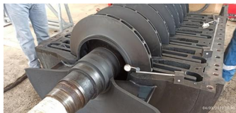
-Démontage du rotor
