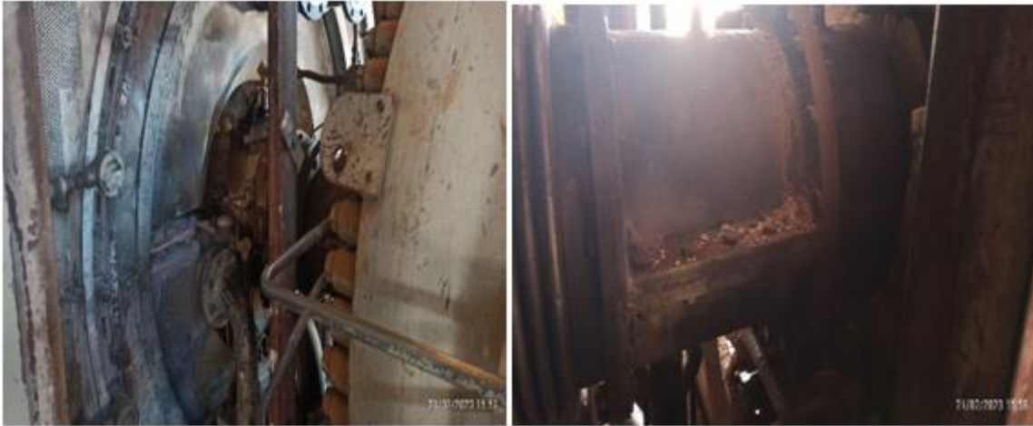
-Démontage des carters d'accouplement coté charge
