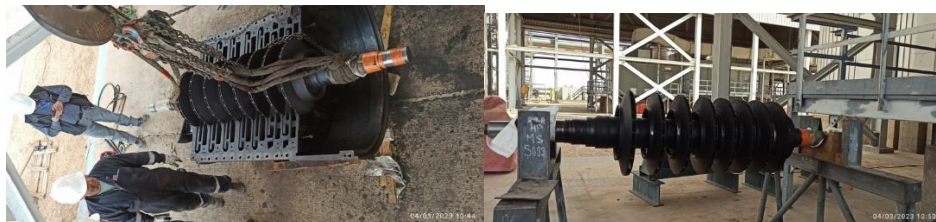
-Démontage des labyrinthes des deux demis du stator
