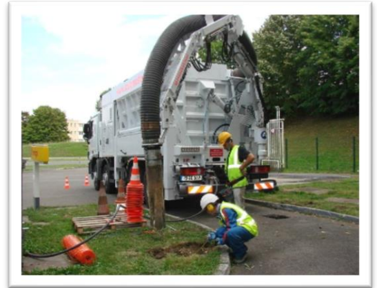
Photo 3.4.1.1) Réalisation du sondage SC2
