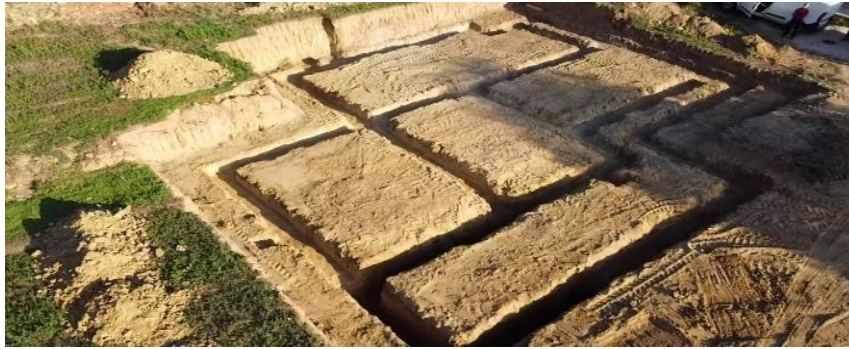
Photo 4.2.1) Terrassement de la grande masse [28]
