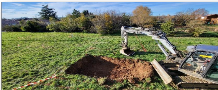
Photo 4.2.2) Terrassement en déblai [28]
