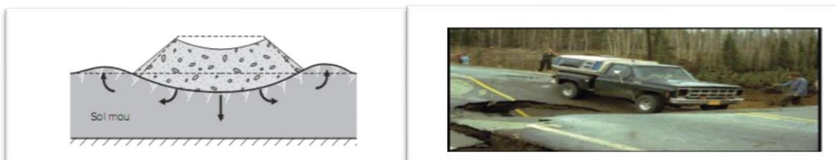
Photo 1.3.1 Rupture par poinçonnement [7]
