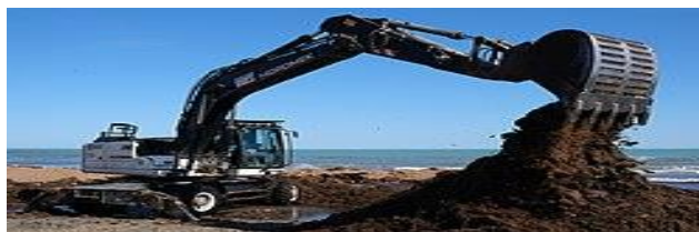
Photo 2.8.2) Pelle hydraulique (ou Pelle mécanique) [14]
