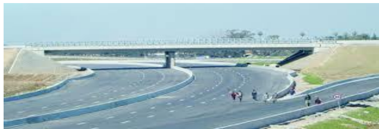
Photo 2.5.1) Ouvrages routiers et autoroutiers [12]
