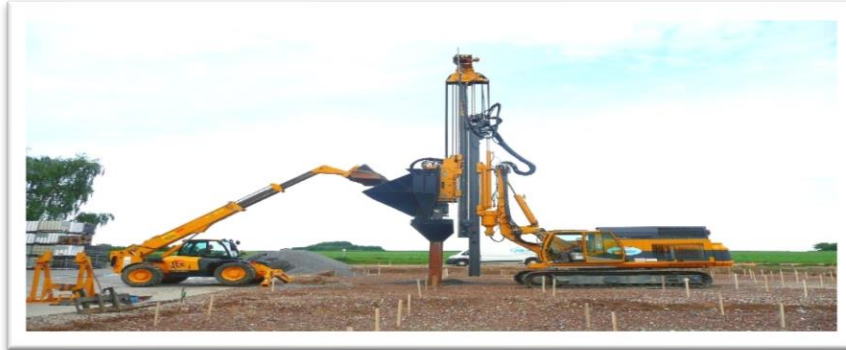
Photo 2.3.2) Amélioration des caractéristiques mécaniques du terrain [10]
