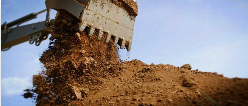
Photo 4.2.3) Terrassement en remblai [28]
