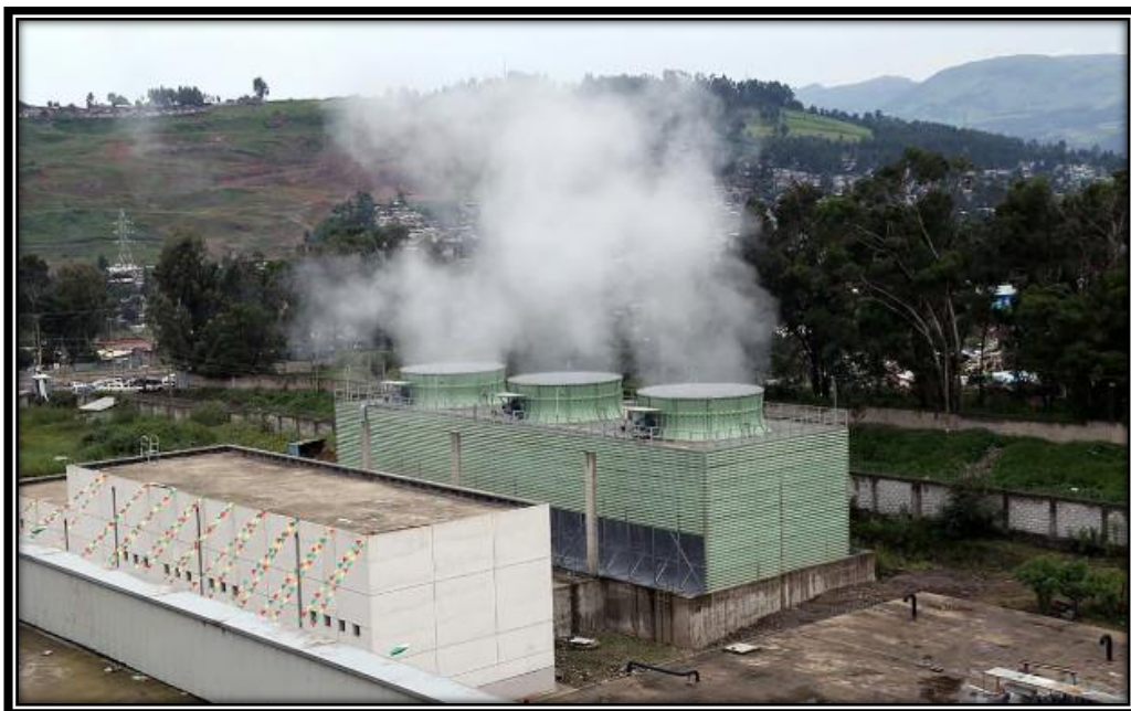
Figure 12 : Centre d'incinération des déchets. (Source : www.jeuneafrique.com)
