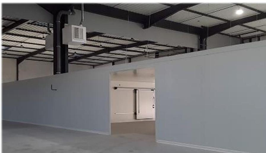
Figure 60 L'utilisation de panneau sandwich au niveau des pavillons pour la séparation entre les espaces Source : internetvergelijken.com
