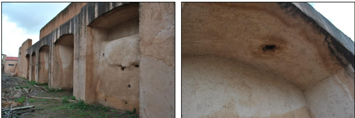
Photo 58. A droite. Le trou qui traverse le chemin de ronde. A gauche, succession d'arcades aveugles qui supportent le chemin de ronde. Source auteur du mémoire Avril 2018
