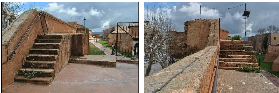
Photo 67. Continuité du chemin de ronde au niveau du flanc Nord. Source auteur du mémoire Avril 2018
