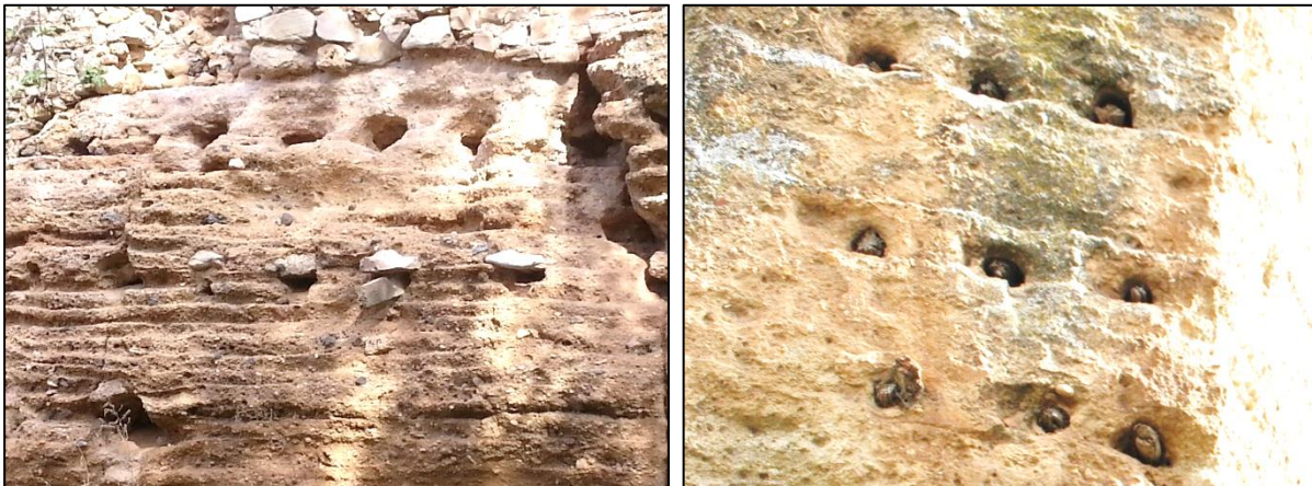
Photo 137. Présence de pierre au-dessus des trous, fragment "Cerisiers" (à gauche), et présence de restes de boulines au niveau d'une jonction, fragment BS, AGADIR (à droite). Source auteur du mémoire Avril 2018
