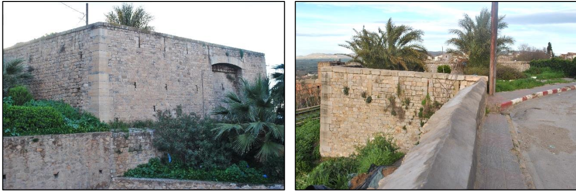
Photo 129. Vues sur le bastion 5. Source auteur du mémoire Avril 2018
