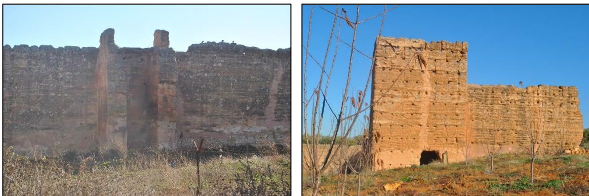
Photo 108. La tour médiane, et la tour de l'angle Nord-Ouest. Source auteur du mémoire Mars 2018
