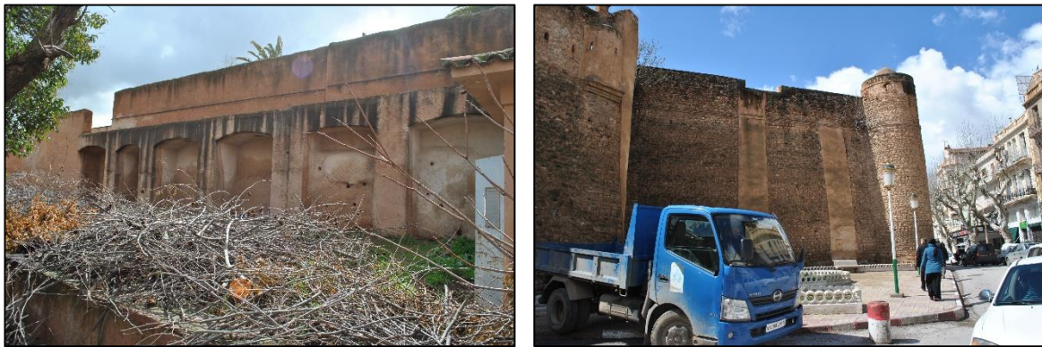
Photo 161. Application intégrale d'enduit sur arcades aveugles française (à gauche), et en bande sur les parements extérieurs (à droite). Source auteur du mémoire Avril 2014
