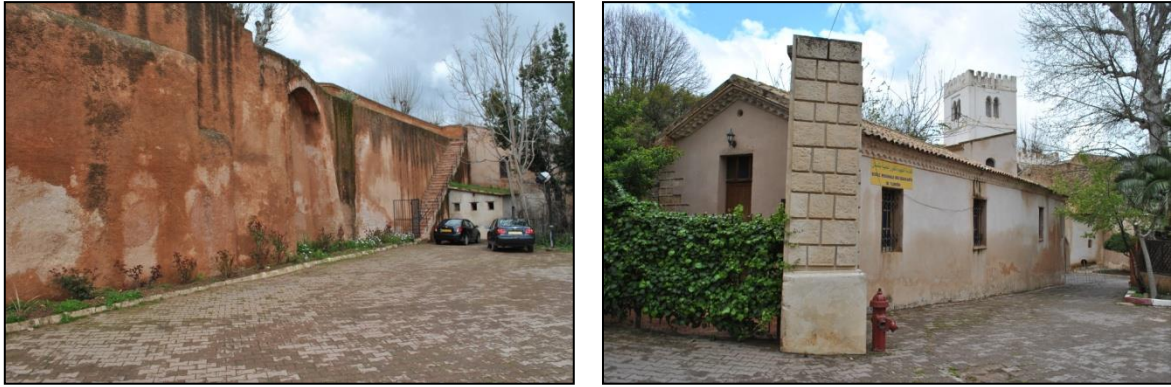
Photo 62. Liaison de l'enceinte avec les pavillons Ouest de la période française. Source auteur. Avril 2018
