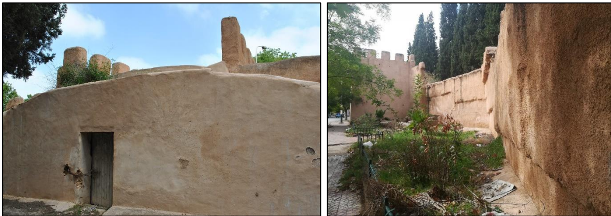
Photo 93. Vue sur l'accès de l'espace intérieur de la tour (à gauche), et sur sa distance de flanquement (à droite). Source auteur du mémoire Avril 2018
