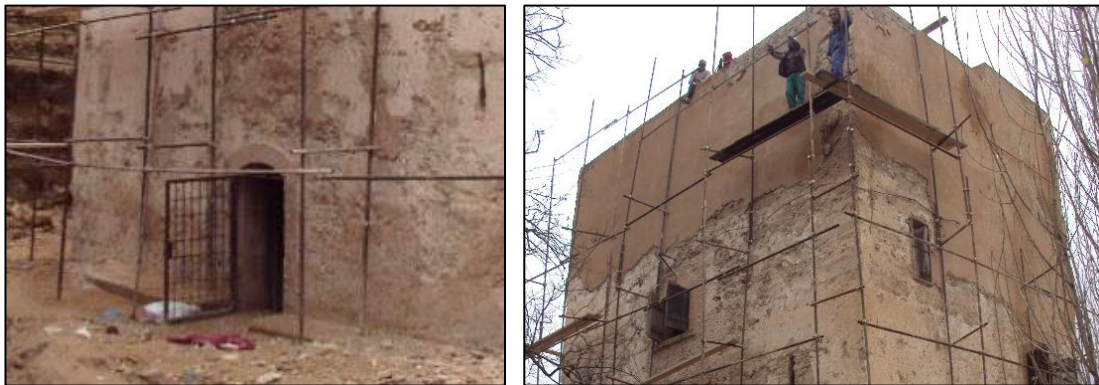
Photo 166. Travaux de nettoyage et de reprise d'enduit. Source OGEBC
