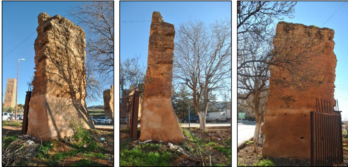
Photo 111. Vues sur les restes de la tour. Source auteur du mémoire Mars 2018
