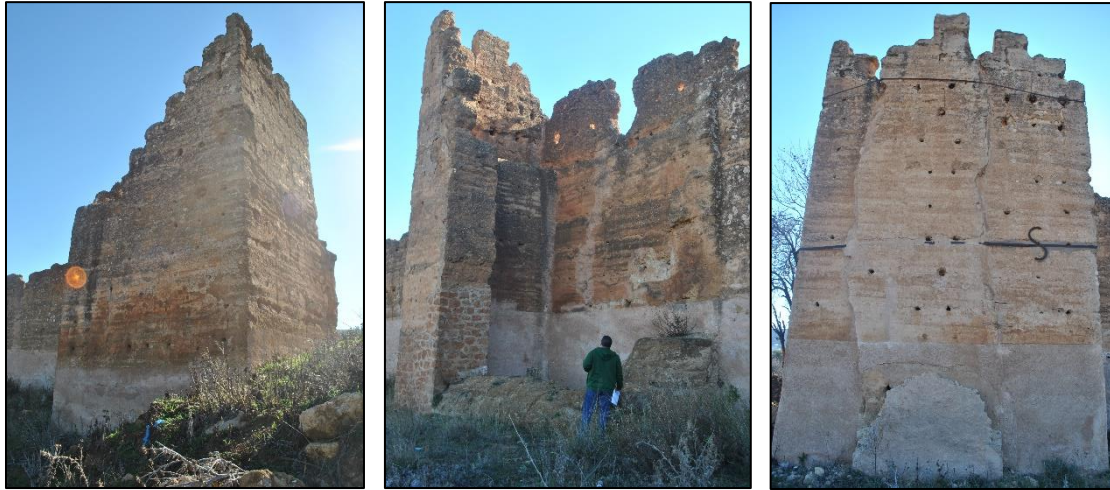
Photo 104. Vues sur la tour de l'extrémité Est (à gauche), une tour médiane (au centre) la tour de l'extrémité Est (à droite). Source auteur du mémoire Mars 2018
