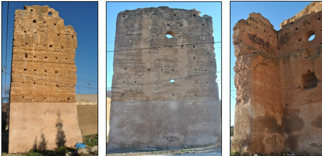
Photo 102. Vues sur la tour avec la saignée de la voûte sur la photo de droite. Source auteur du mémoire Mars 2018
