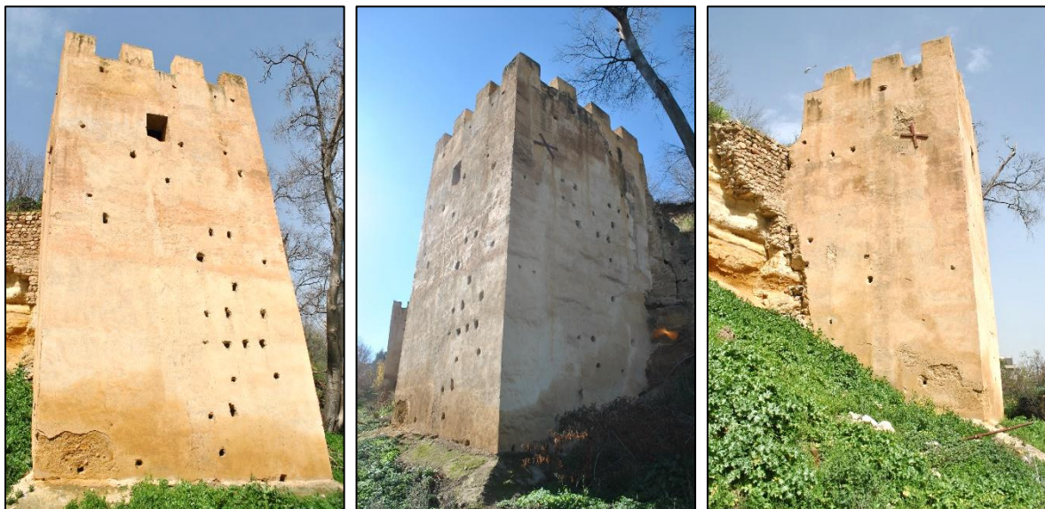
Photo 26. Vues sur les trois faces accessibles du fragment A1.T3. Source auteur du mémoire Avril 2018
