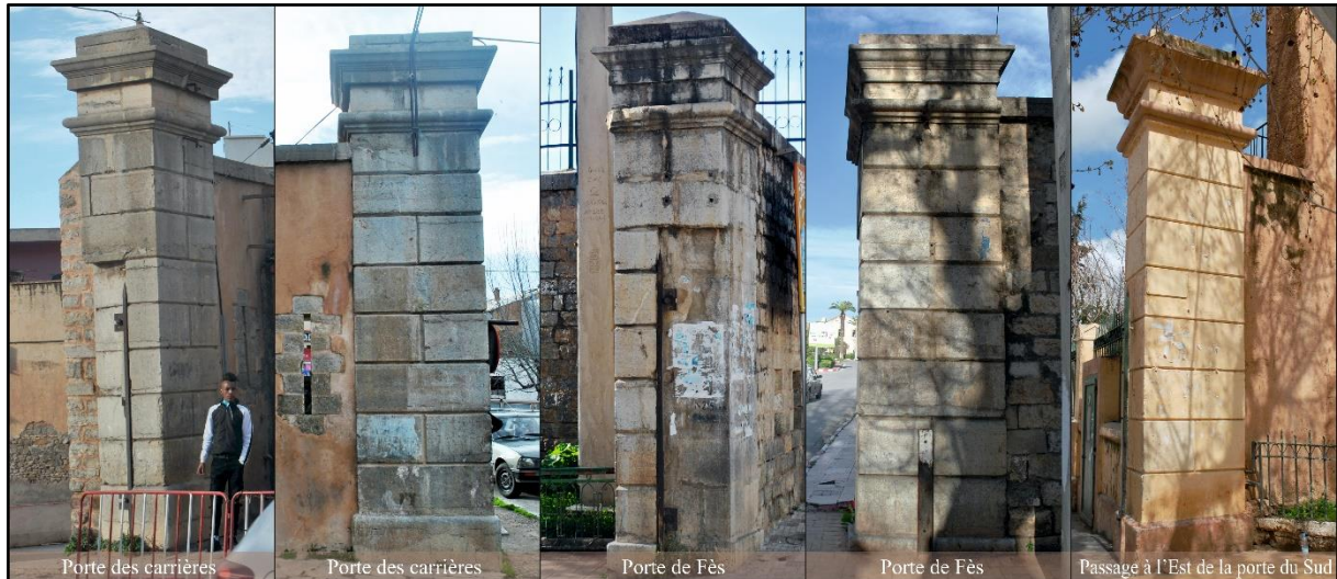
Photo 128. Vues sur les éléments de scellement en pierre de portes métalliques. Source auteur du mémoire Avril 2018
