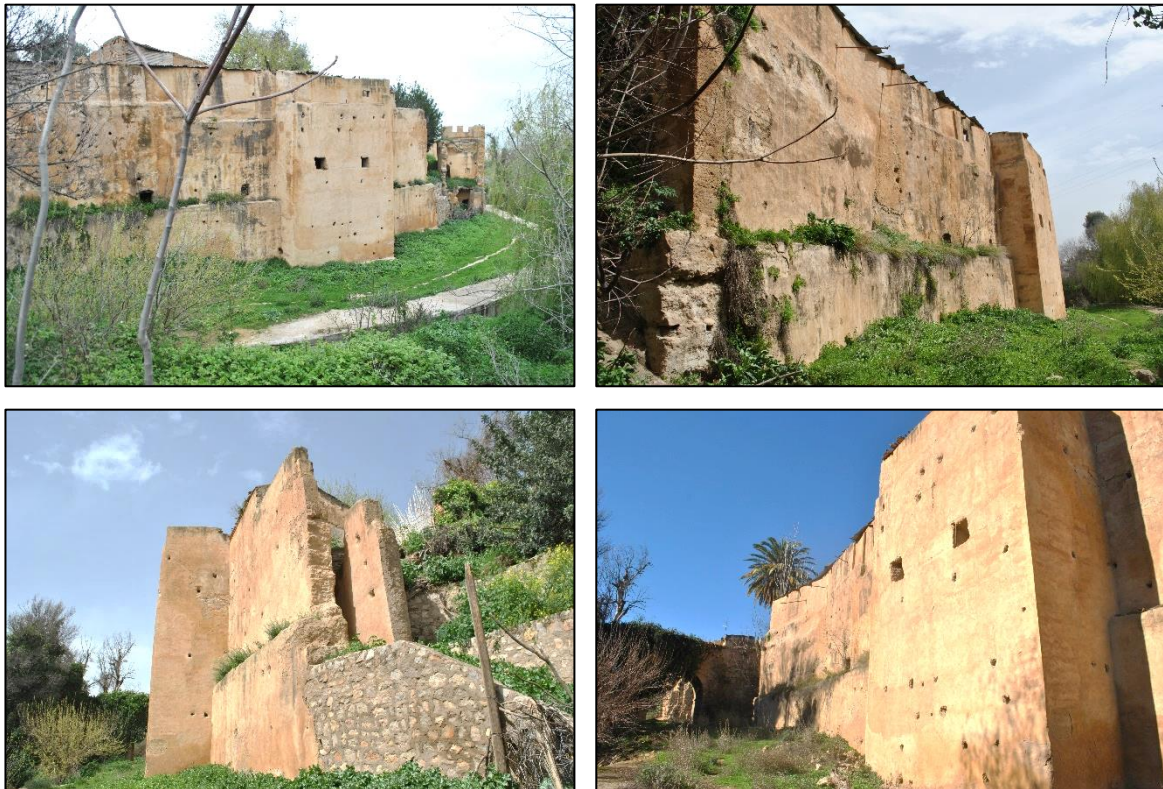
Photo 28. Vues extérieures sur le fragment A1.T5. Source auteur du mémoire Avril 2018
