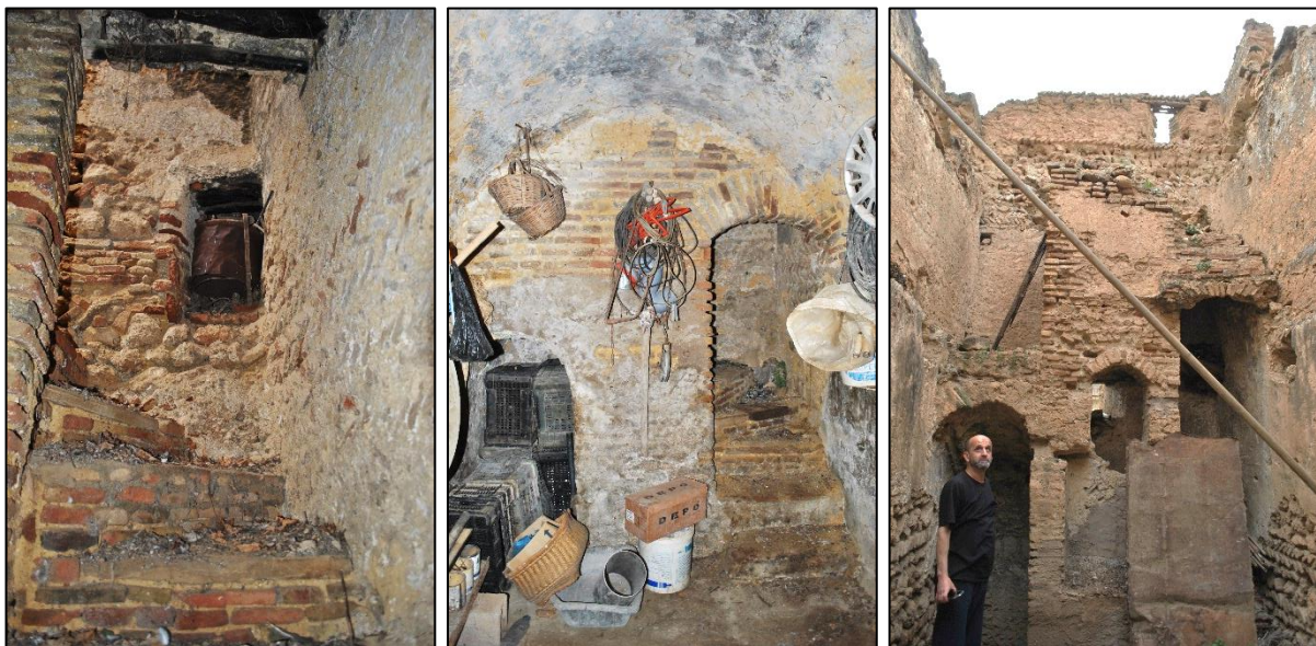
Photo 41. Vues sur l'espace intérieur. Source auteur du mémoire Janvier 2018
