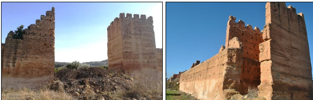
Photo 105. Vue générale du fragment (à droite), et sur les deux tours carrées (à gauche). Source auteur du mémoire Mars 2018
