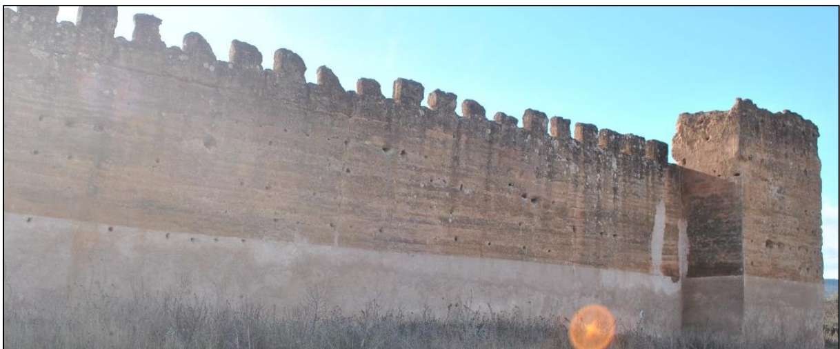
Photo 173. Aspect général après l'application de l'enduit à la base du fragment, et sur une fissure. Source auteur du mémoire Avril 2018
