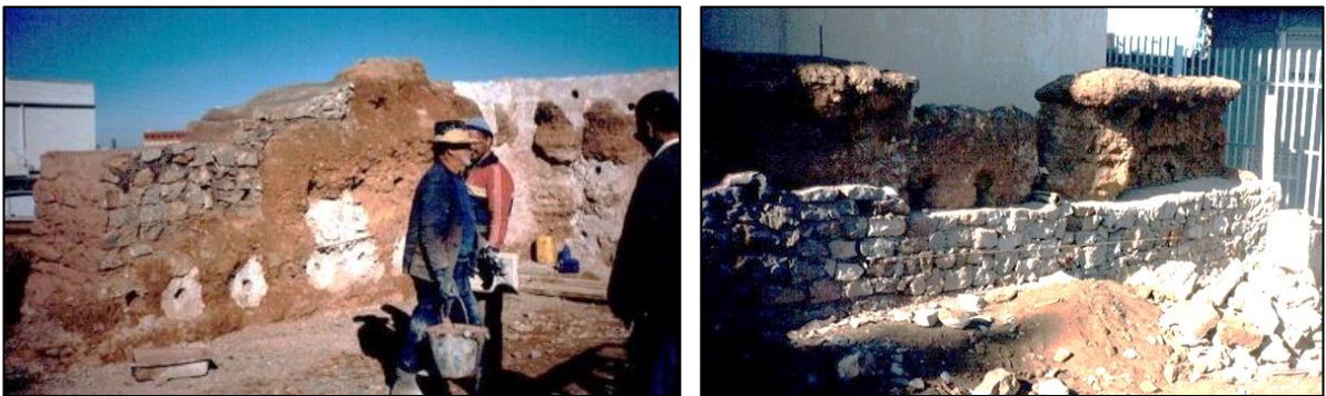
Photo 175. Restitution de volume en pierre lors des travaux de 1999. Source OGEBC
