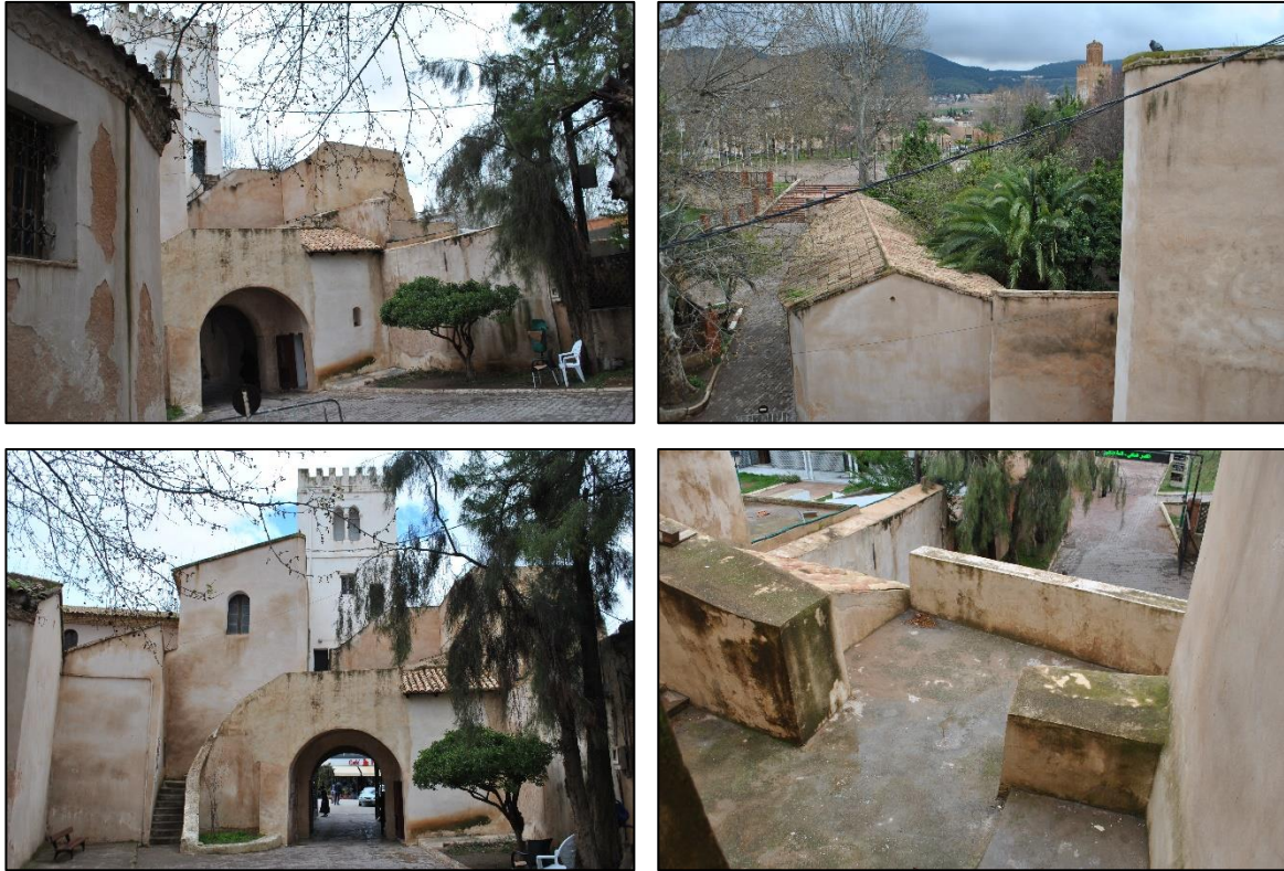
Photo 64. Pavillons Ouest incluant l'entrée. Source auteur du mémoire Avril 2018
