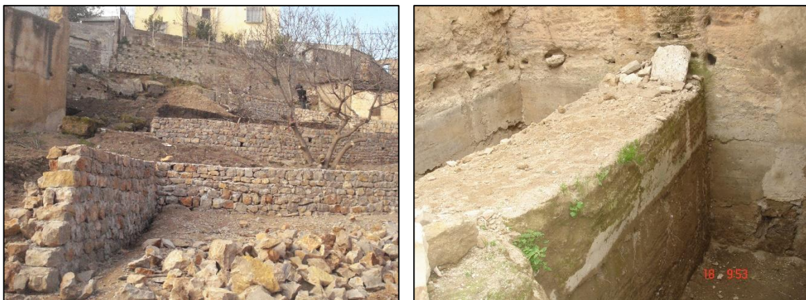
Photo 146. Travaux d'aménagement (à gauche) et de confortement (à droite) du fragment. Source OGEBC
