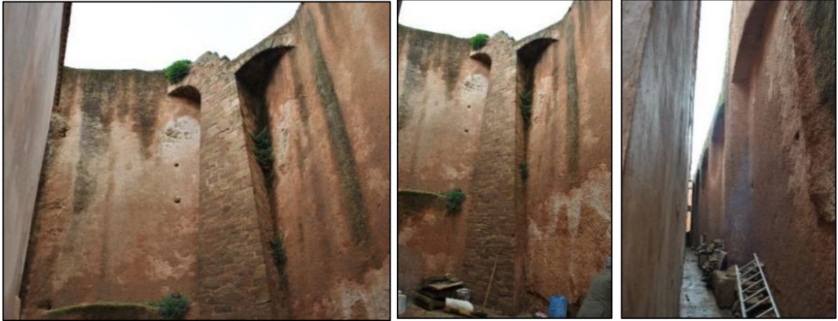
Photo 60. Arcades en pierre supportant le chemin de ronde derrière la mosquée. Source auteur du mémoire Avril 2018
