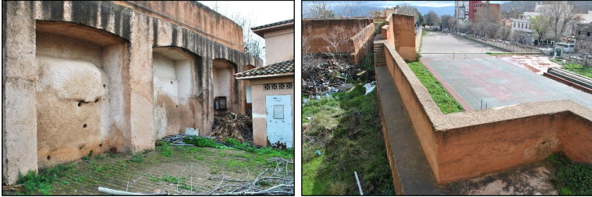
Photo 78. Trous de coffrage (à gauche), et courtine du flanc Sud de l'enceinte (à droite). Source auteur du mémoire Avril 2018
