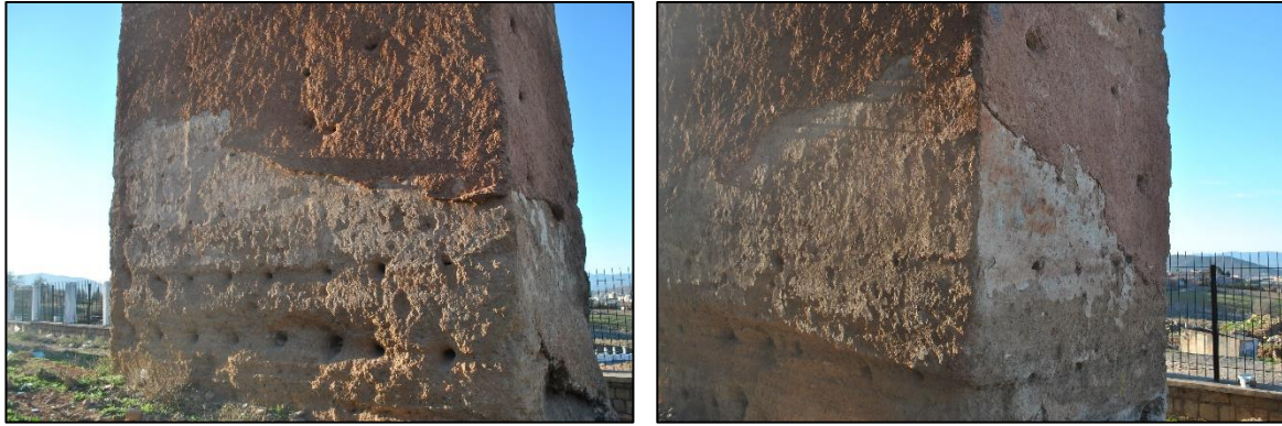
Photo 172. Décapage du sol après la reprise d'enduit. Source auteur du mémoire Avril 2018
