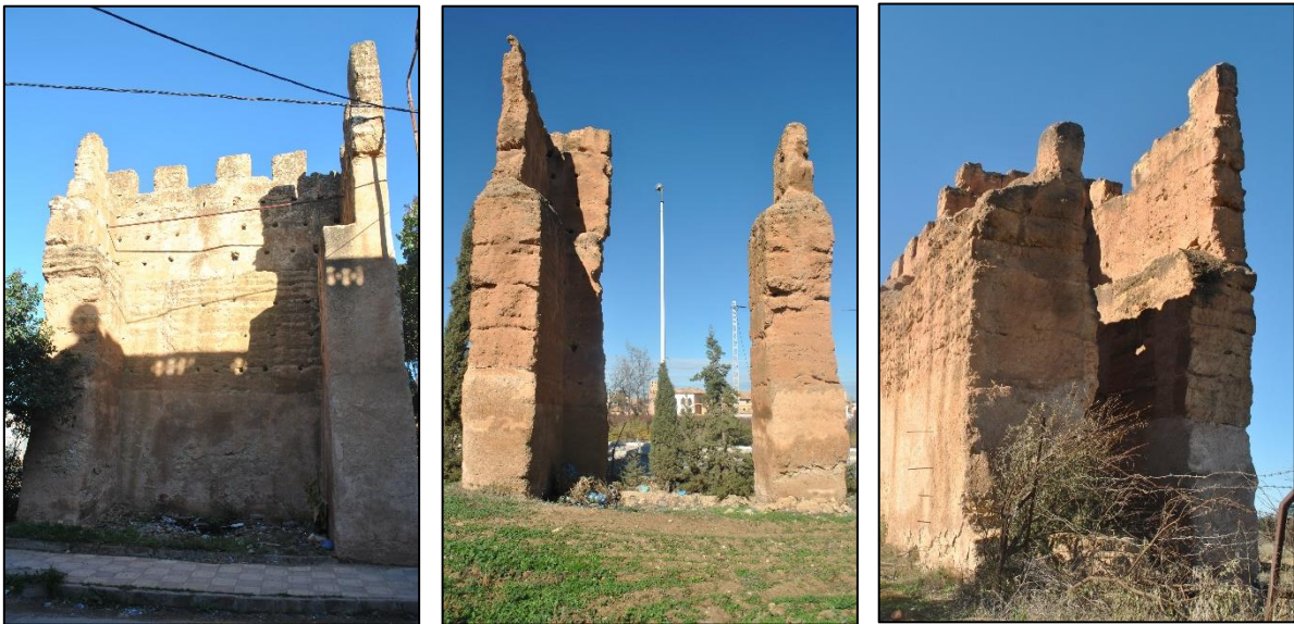
Photo 121. Coupe sur la section du mur au niveau des fragments M.M.8, M.M.15, et M.M.23. Source auteur su mémoire Avril 2018
