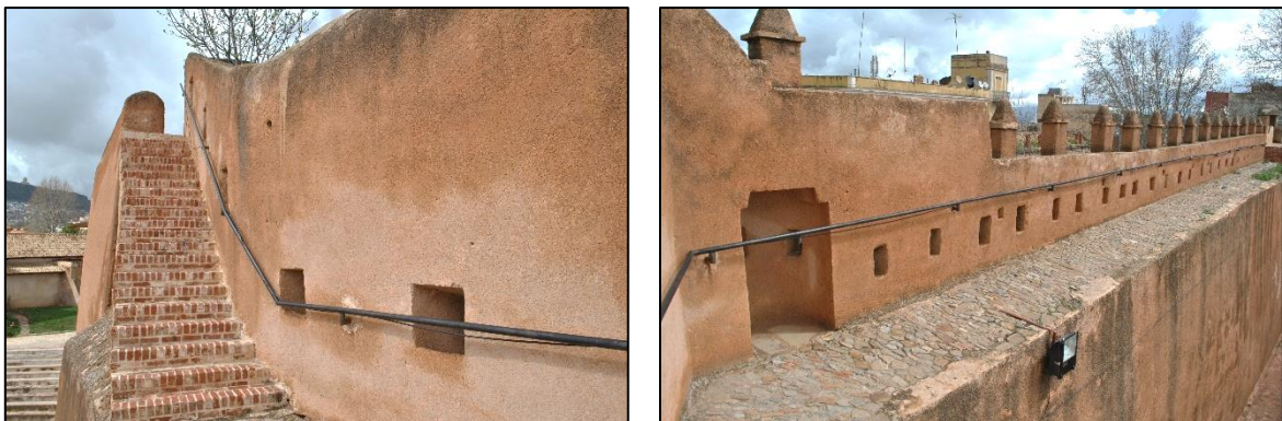
Photo 71. A droite, meurtrières et merlons à pyramidions le long du chemin de ronde pavé. A gauche, revêtement en brique des escaliers au niveau du chemin de ronde. Source auteur du mémoire Avril 2018
