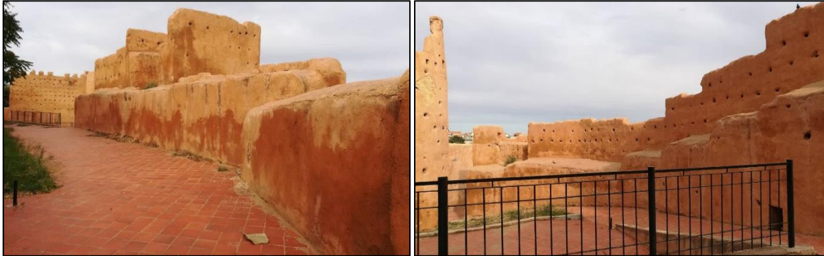
Photo 47. Vues sur le fragment BQ 4. Source Auteur du mémoire Avril 2018
