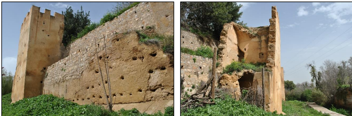
Photo 27. Vues sur le fragment A1.T4. Source auteur du mémoire Avril 2018
