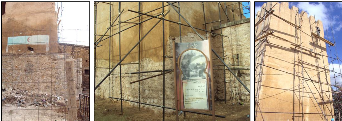
Photo 165. Différentes phases des travaux de 2010. Source OGEBC
