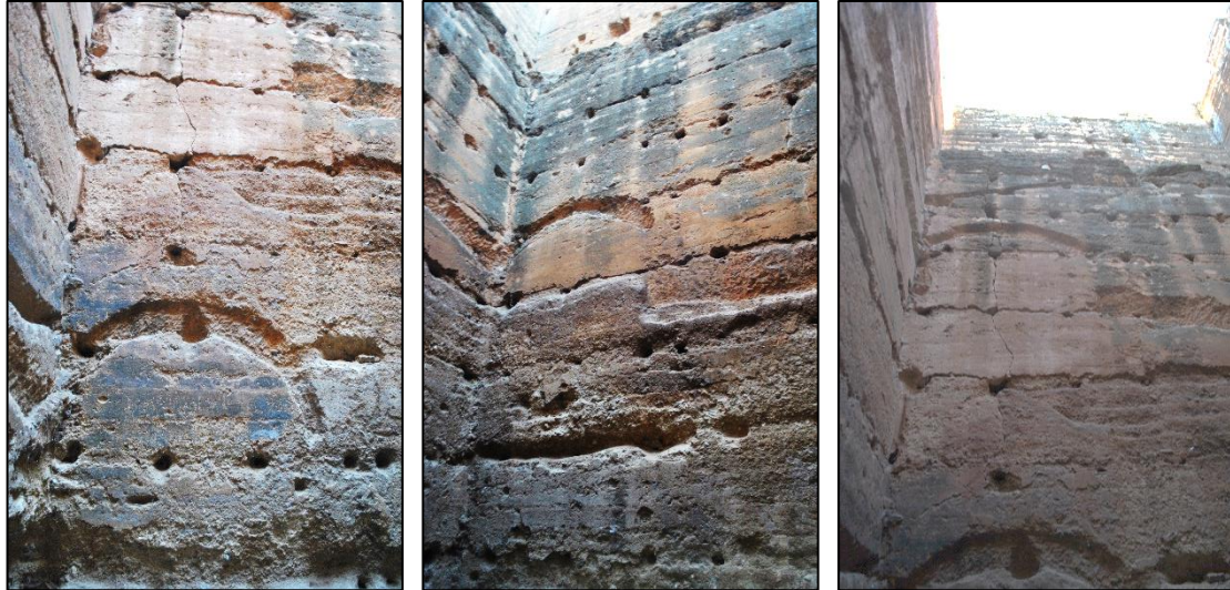
Photo 116. Détails des saignées sur les parements intérieurs. Source auteur du mémoire Mars 2018
