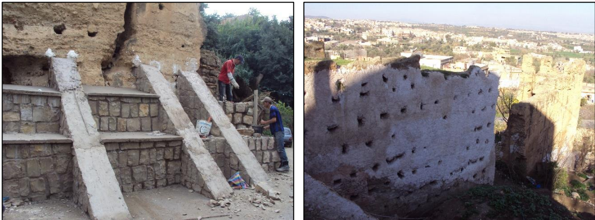
Photo 149. Confortement et application d'enduit sur le fragment. Source OGEBC
