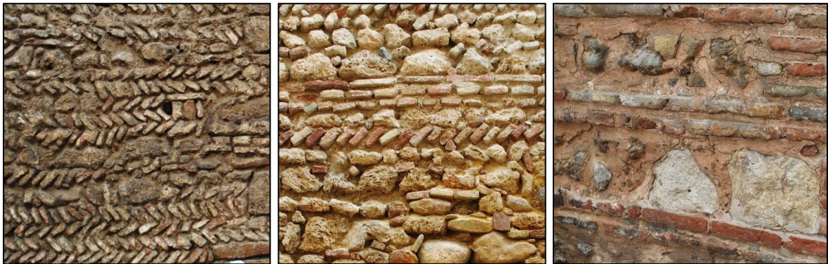
Photo 142. Système constructif mixte pierre et brique appareillées (AL MACHUAR à droite, A.T4 AGADIT au centre, et Bâb AL KHAMIS à gauche). Source auteur Juillet 2018
