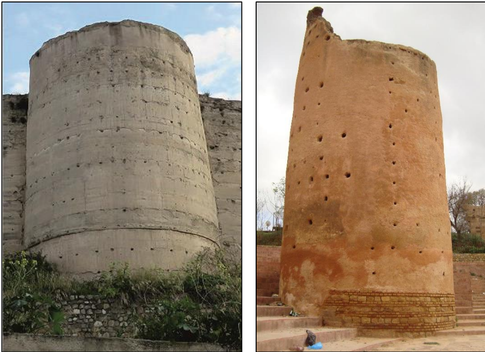
Photo 3. A droite une tour de Bâb AL QARMADIN. Source auteur du mémoire 2010. A gauche tour de la muraille ALBAYCIN à Grenade. Source Antonio ALMAGRO
