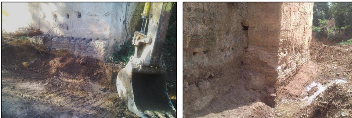
Photo 145. Décapage au pied du mur dans la zone Nord-Est d'AGADIR. Source OGEBC
