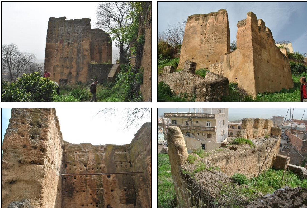
Photo 31. Vues sur les deux tours du fragment. Source auteur du mémoire Avril 2018
