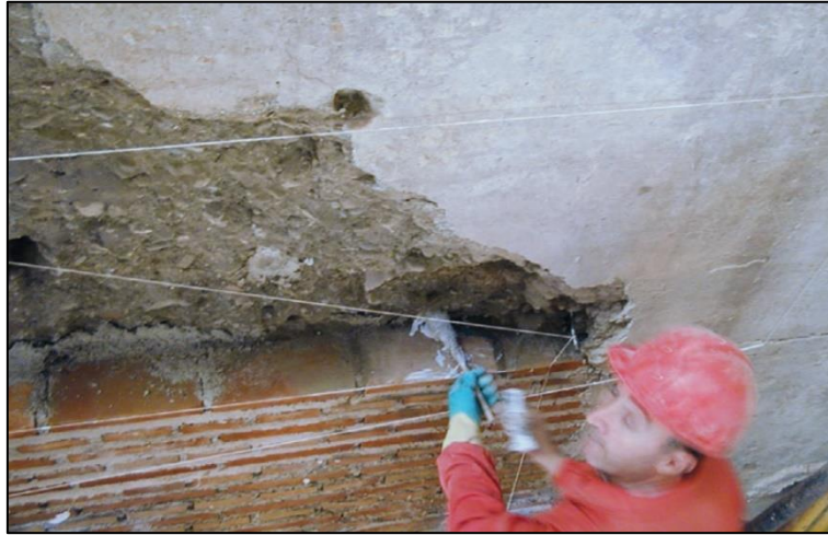
Photo 17. Ancrage des tiges en bois. Source Antonio ALMAGRO 218
