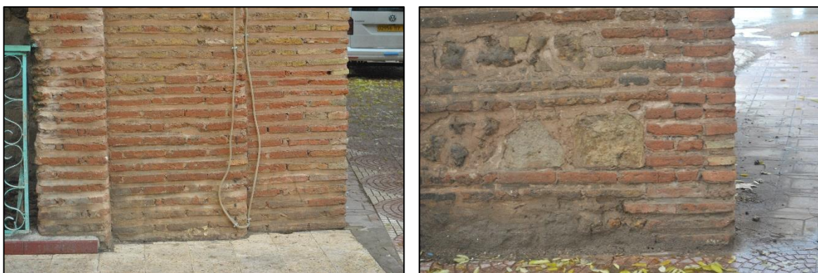
Photo 95. Réparation en brique sur la face Est (à gauche), et réparation en pierre sur la face Ouest (à droite). Source auteur du mémoire Octobre 2017
