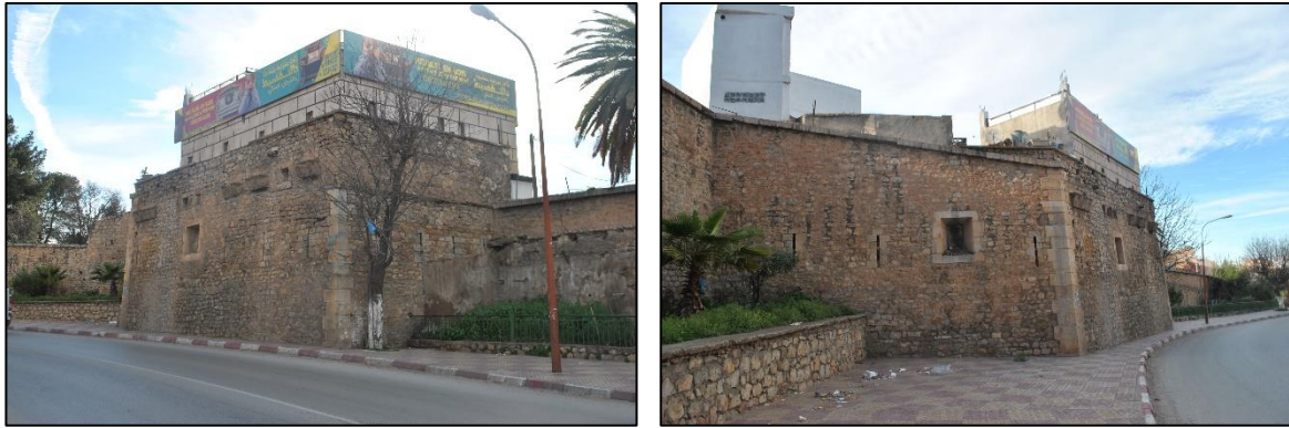
Photo 135. Vues extérieures sur le bastion 19. Source auteur du mémoire Avril 2018
