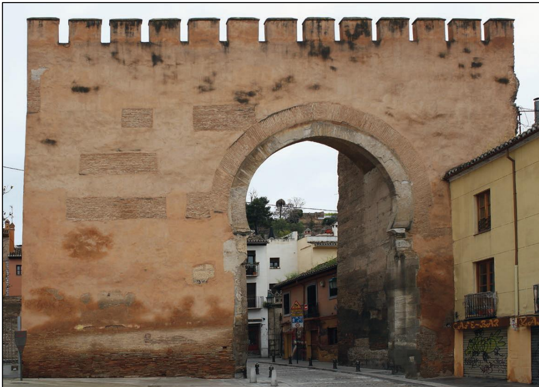
Photo 13. Etat de conservation de la porte en 2016. Source Antonio ALMAGRO 213
