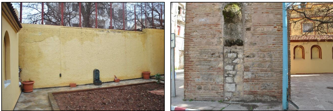
Photo 96. La face Ouest du mur au Sud de la porte (à gauche), et le départ de mur au Nord (à droite). Source auteur du mémoire Octobre 2017
