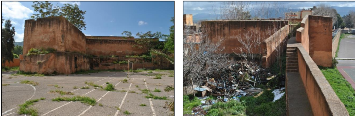
Photo 52. A droite, vue sur la courtine et son chemin de ronde. A gauche, la tour du lycée. Source auteur du mémoire Avril 2018
