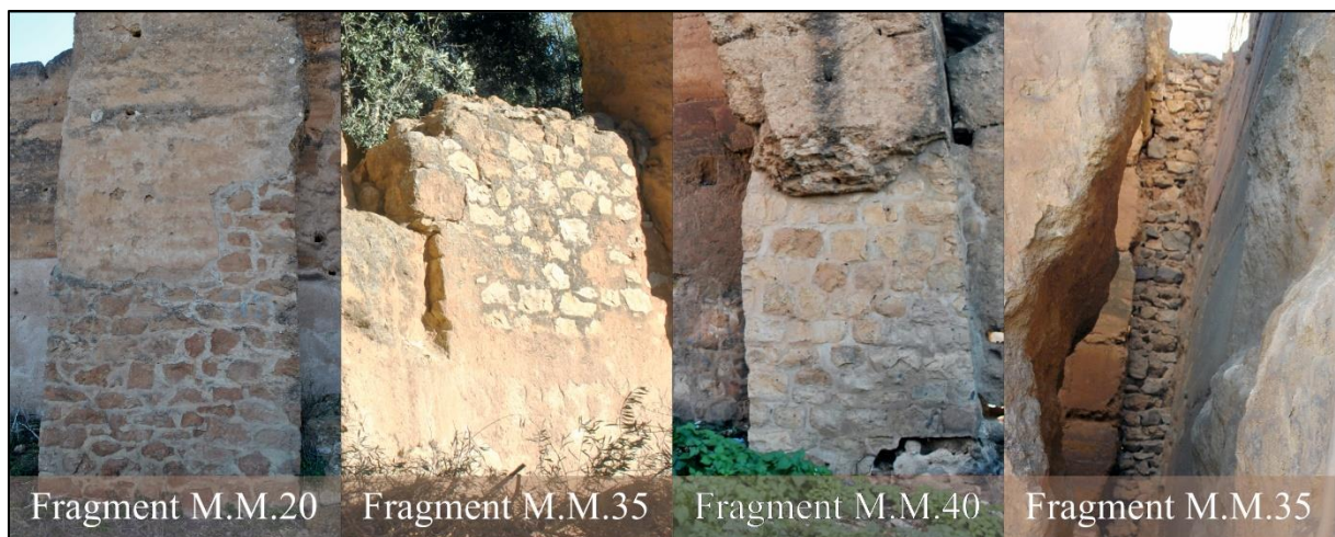
Photo 169. Restitution de volume, et colmatage de fissures. Source auteur du mémoire Avril 2018
