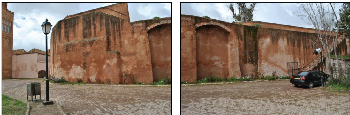
Photo 61. Chemin de ronde à niveaux, supporté par un arc aveugle. Source auteur du mémoire Avril 2018
