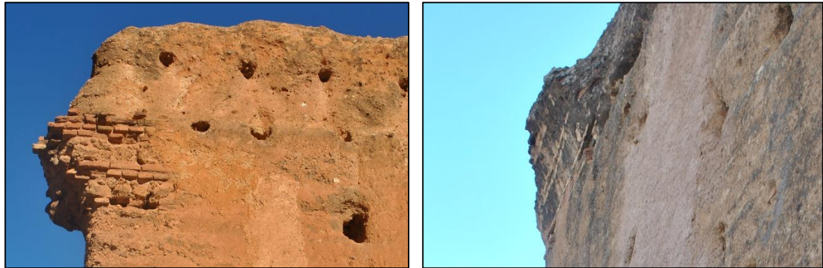
Photo 119. Vues sur les détails constructifs en brique pleine. Source auteur du mémoire Mars 2018
