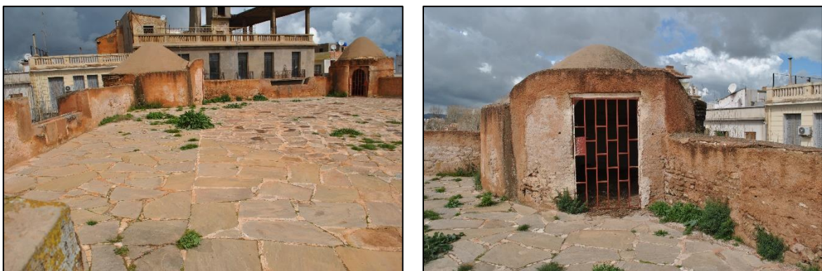
Photo 69. Vue générale sur la terrasse du bastion. Source auteur du mémoire Avril 2018
