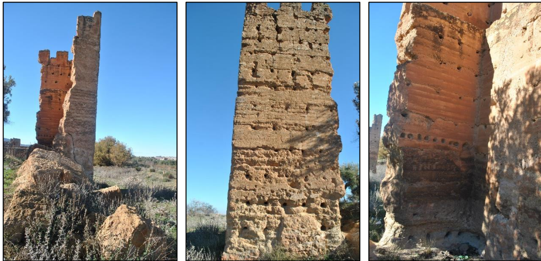
Photo 106. Vues sur la tour et ses perforations. Source auteur du mémoire Mars 2018
