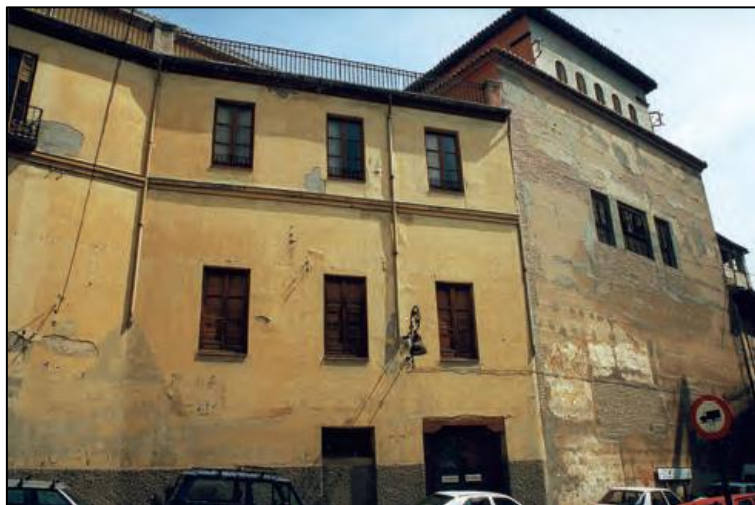
Photo 16. Aspect extérieur avant l'intervention. Source Javier GALLEGO ROCA 216
