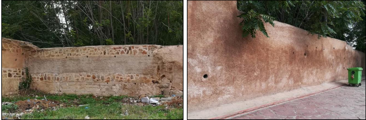
Photo 164. Restitution de volume (à gauche), reprise d'enduit et canalisation d'eau au pied du mur (à droite). Source auteur du mémoire Octobre 2018
