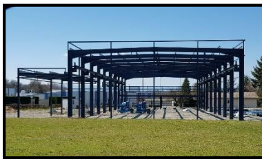
Figure 14 : Portique métallique
