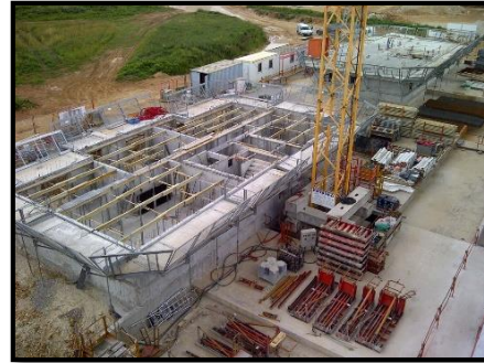
Figure 6 : Exemple d'un atelier précaire
