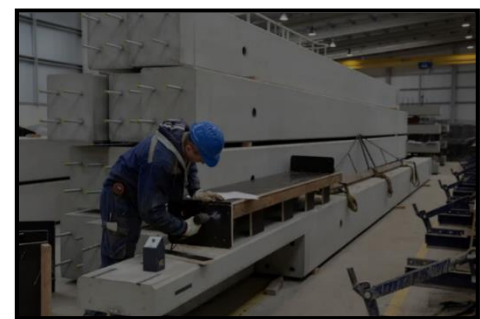
Figure 8 : Préfabrication en usine
