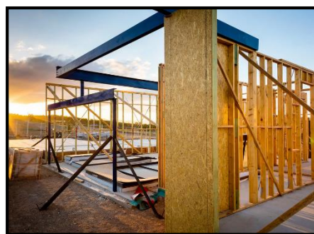
Figure 17 : ossature en bois
