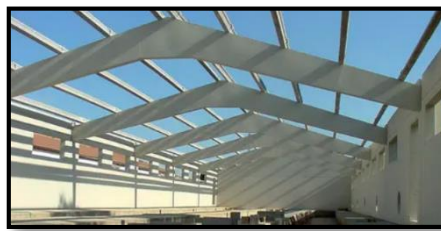
Figure 15 : Portique en béton armé
