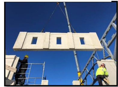
Figure 21 : panneaux en béton
