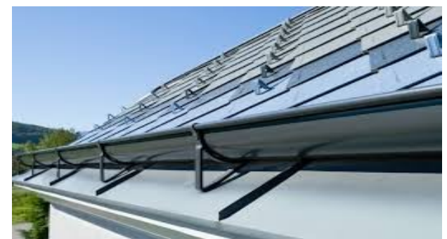
Figure 79: Gouttières intégrées aux toitures
