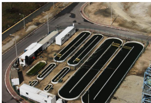
Figure I. 3 : Photographie d'un bassin ouvert de culture de la Nannochloropsis sp. à grande échelle (Greenwell, et al., 2010)
