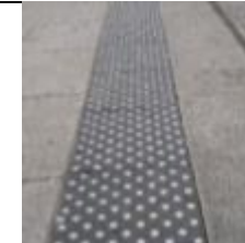
Clou passage piéton pour personnes à mobiliter réduite Espace : Dans tout le secteur
