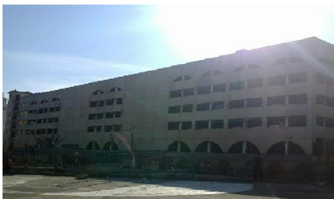
Figure 79:parking à étages 104
