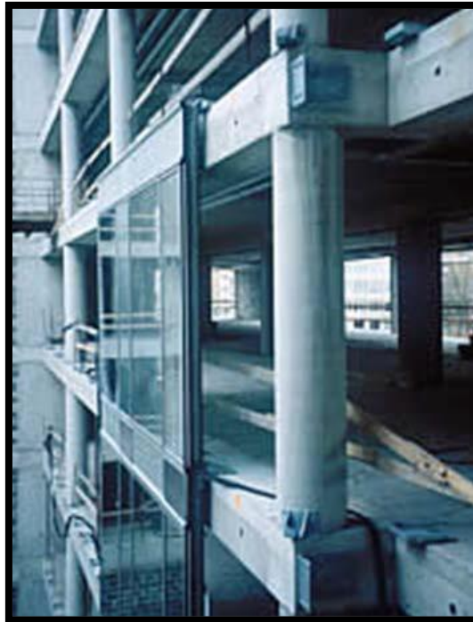
Figure 85 : Technique de montage des murs rideaux
