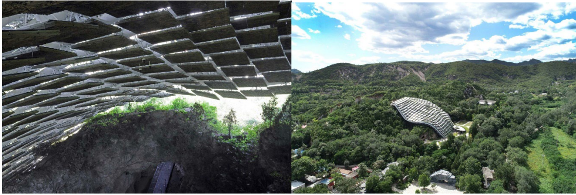
Figure 34 L'abri protecteur de site. (Archdaily)
