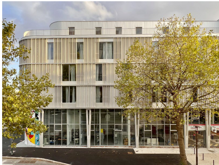
Figure 79 Façade de l'école (archdaily.com).
