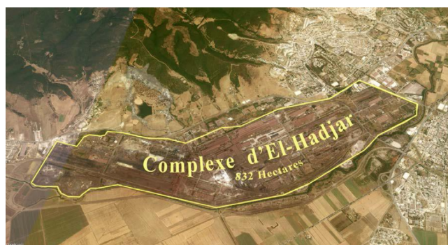
FIGURE I.1 – Vue satellite du complexe d'El-Hadjar.
