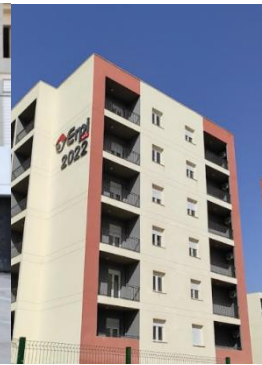
Figure 130. Façade habitat collectif
