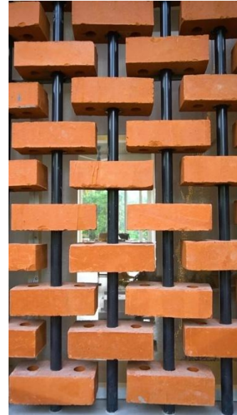
Figure 181. Brise soleil en brique
