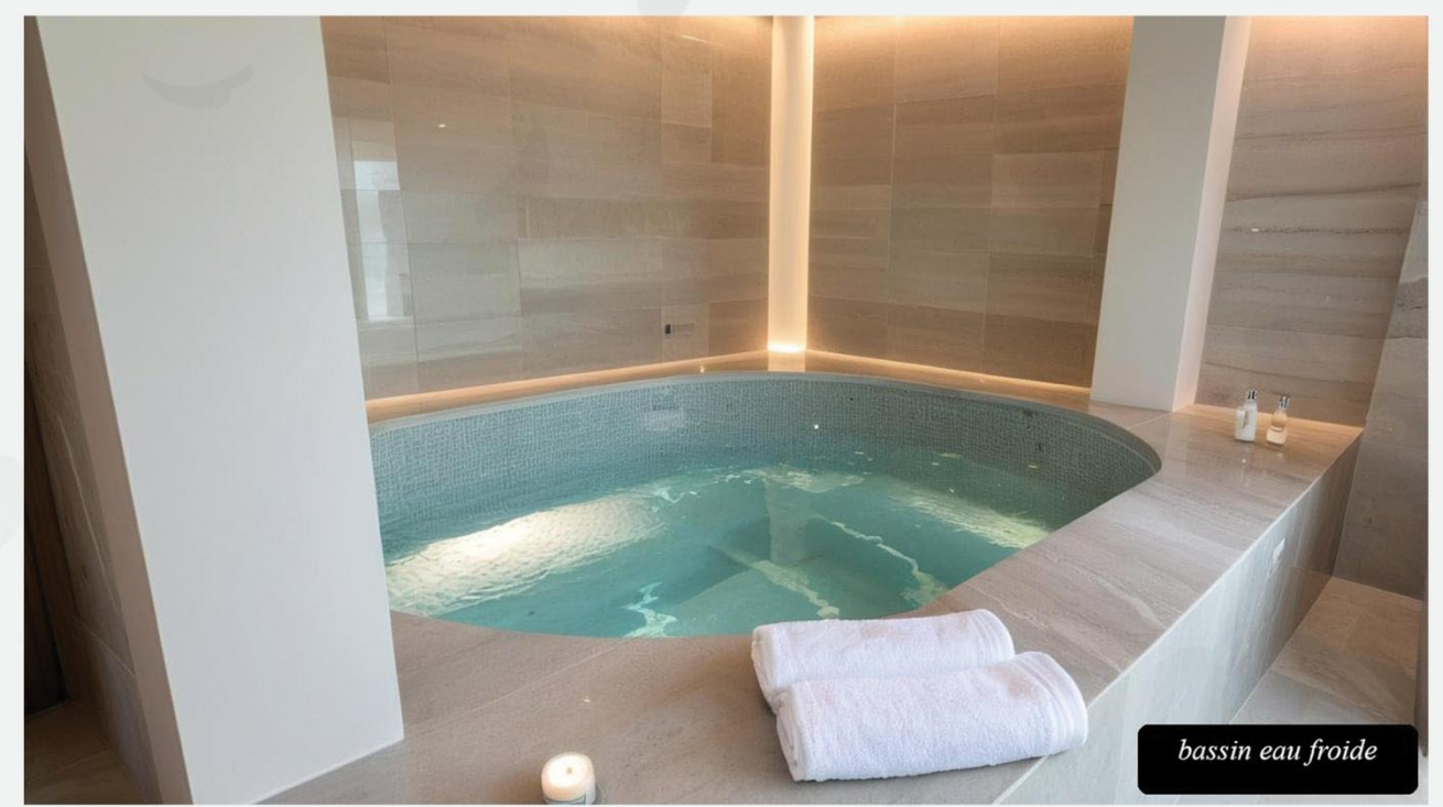
Figure 236. Vue d'intérieure bassin eau froide
