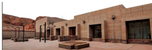
Figure 179. Vue extérieure de projet
