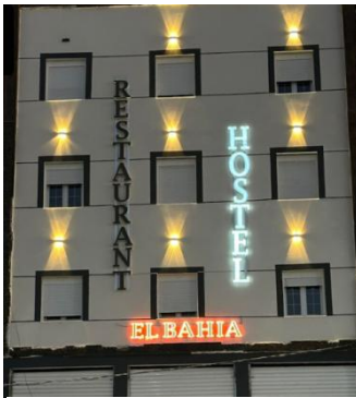
Figure 131. Façade hôtel el Bahia
