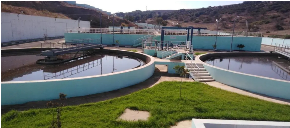
FIG. 1.9 : Station d'épuration d'Ain El Kihel [1]
