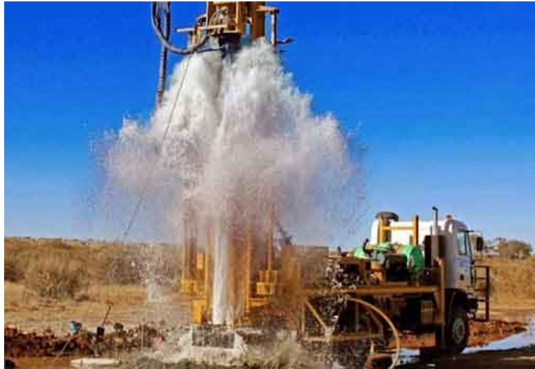
FIG. 1.2 : Installation de forage hydraulique [3]
