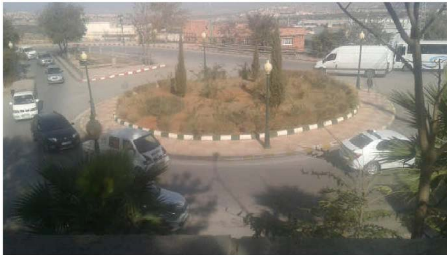
Figure 21 Le rond point qui mène vers la prison février 2017 .
