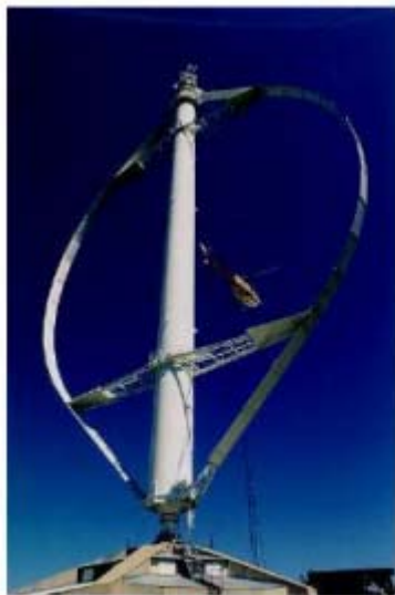
Éolienne de type Darrieus.
