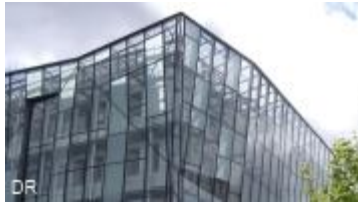
Figure54. La façade VEA
