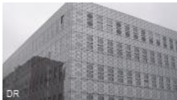
Figure53. La façade VEC
