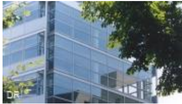
Figure52. La façade VEP
