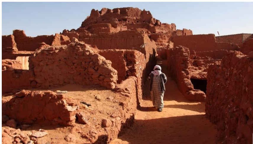
figure 1.14 : Un exemple de Ksar dans le Sahara algérien (Timimoune) la sensibilité de la brique en terre crue à l'eau
