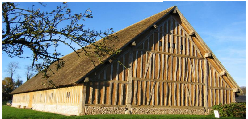
figure 1.5: Construction en Torchis, en Normandie. (France)[15]
