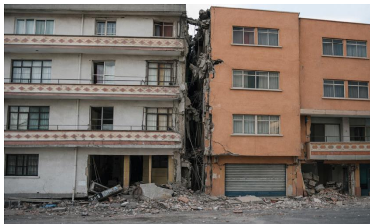
Figure 2.1 : Exemples de martèlement sismique entre deux bâtiments lors du séisme de Mexico (1985).
