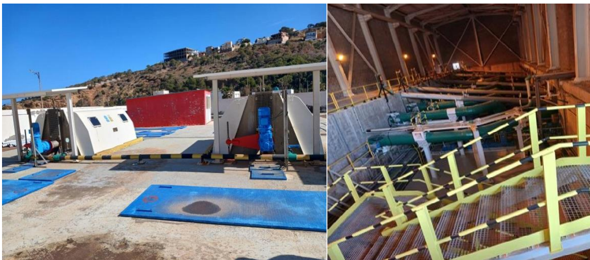
Figure 27 : Filtres rotatifs (origine ; 2025) Figure 28: les 11 pompes à aspiration à vide
