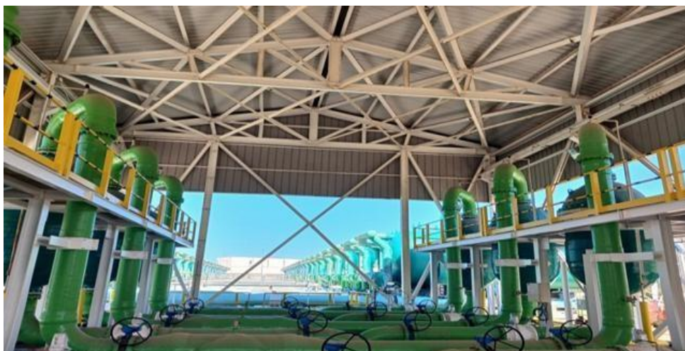
Figure 30 : Filtres à cartouches (origine ;2025)
