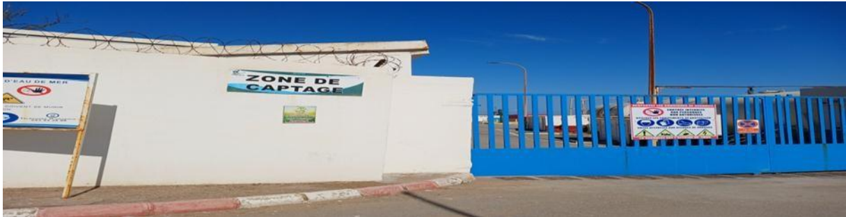
Figure 26 : la zone de captage (origine ; 2025)
