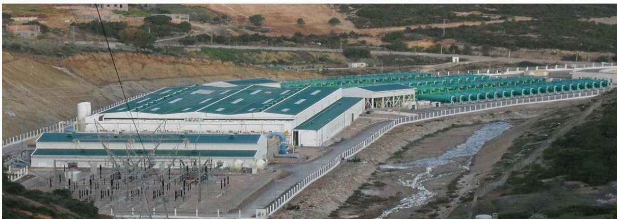
Figure 24 : Photo de la station de dessalement de l'eau de mer de Honaine (c)
