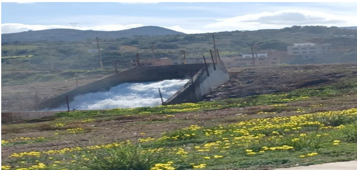
Figure 41 : Rejet de Saumure au Niveau de SDEM HONAINNE.(origine ;2025)
