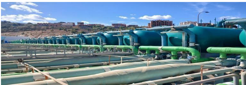
Figure29 : filtres à sables et anthracite (SDEM-Honaine) (origine ;2025)
