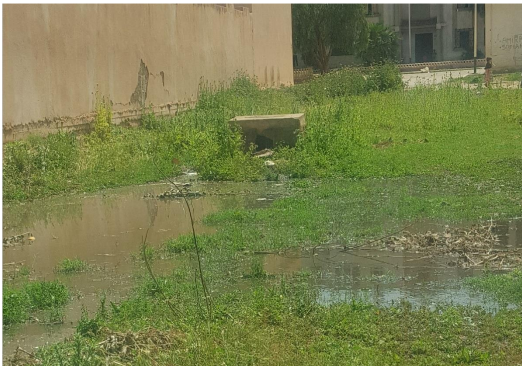
Figure II.10 : Colmatage sur les tuyaux d'égouts (18 Mai 2022).
