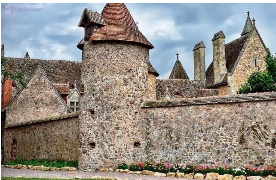
Figure 5 Bâtiment de moyen âge
