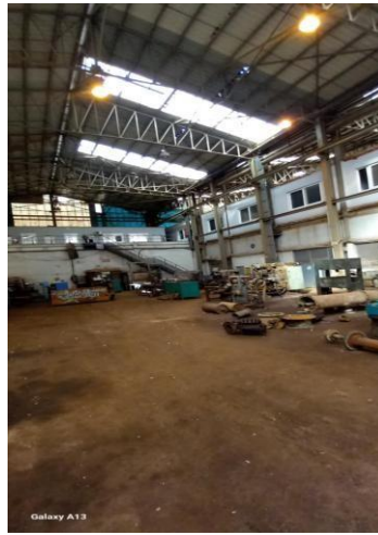
Figure 57 vue intérieur de bâti
