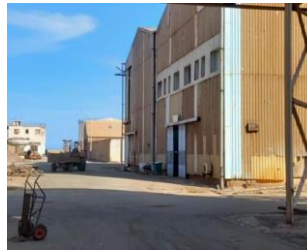
Figure 63 façade de bâti existant
