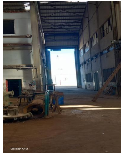
Figure 59 vue intérieur de bâti
