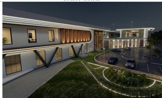
Figure 164 vue sur façade sud
