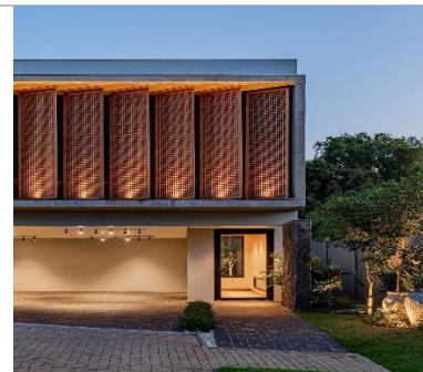
Figure 127 brise solaire rotatifs
