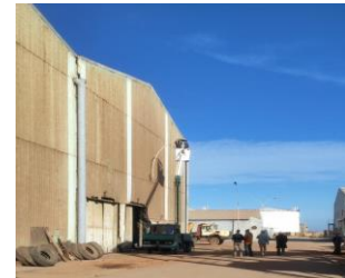
Figure 62 façade de bâti existant
