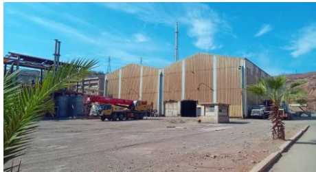
Figure 64 façade de bâti existant
