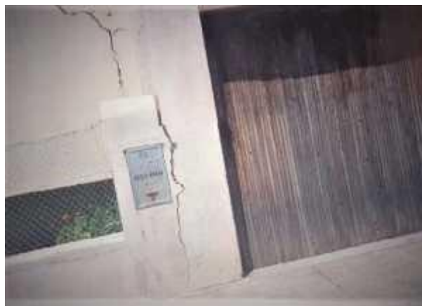
Figure 1. 11 : Soulèvement sous le centre de la fondation (Ejjaaouani H,2008).
