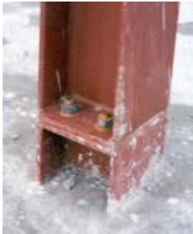
Figure V.1 : joint de poteau par platine d'extrémité
