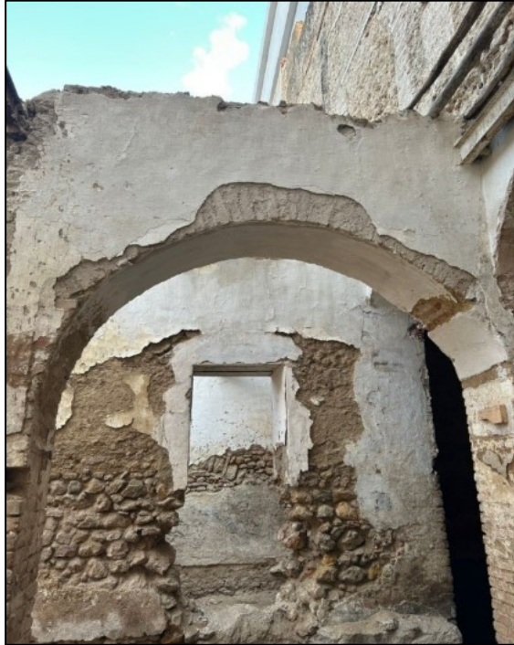
Figure II.18 : Arc en brique pleine
