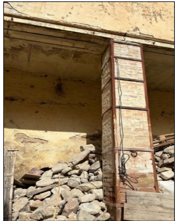
Figure II.23 : Eléments métalliques pour renforcer le poteau
