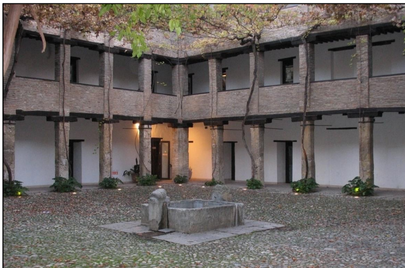
Figure I.15 : Corral Del Carbón (cour du charbon) à Grenada (Andalousie)
