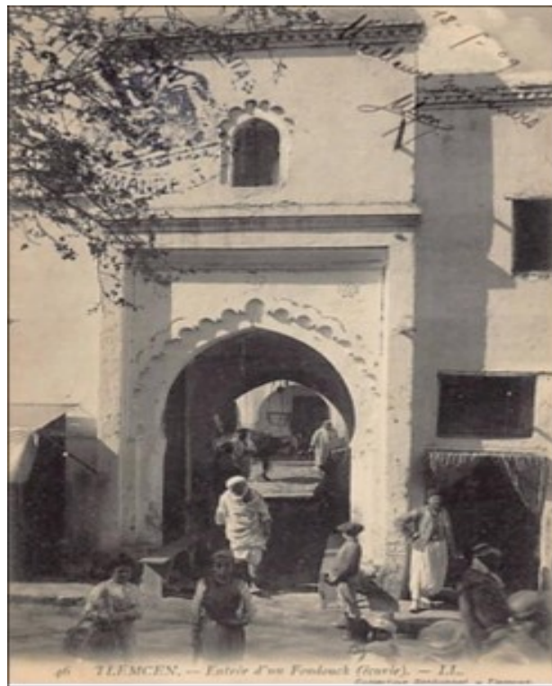
Figure I.19 : L'entrée d'un foundouk à Tlemcen
