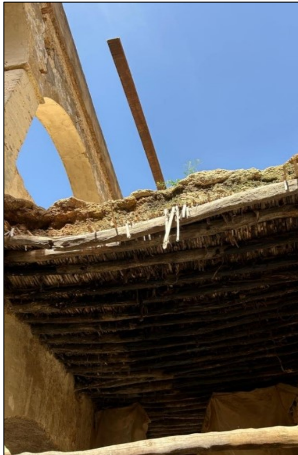
Figure II.25 : Les différentes couches du plancher
