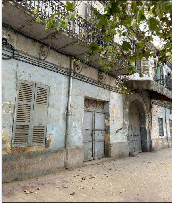
Figure II.1 : Façade principale du Fondouk Benosman
