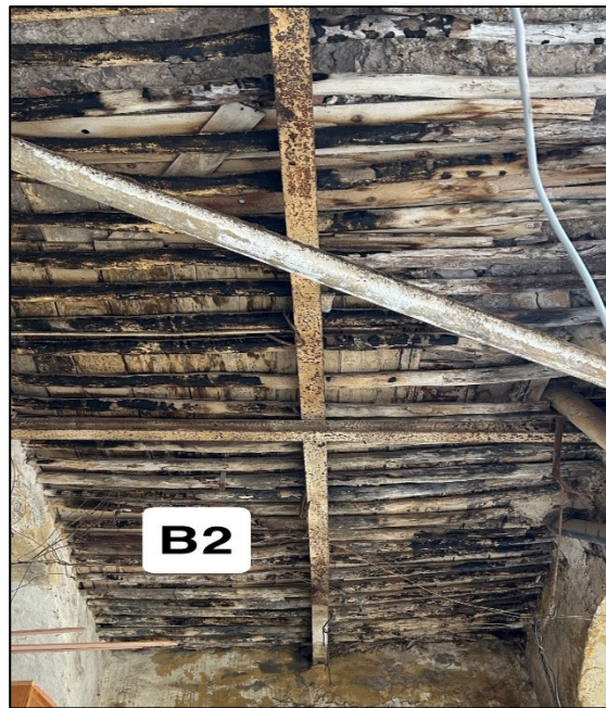
Figure III.31 : Attaque biologique du bois (présence de galeries et perforations)
