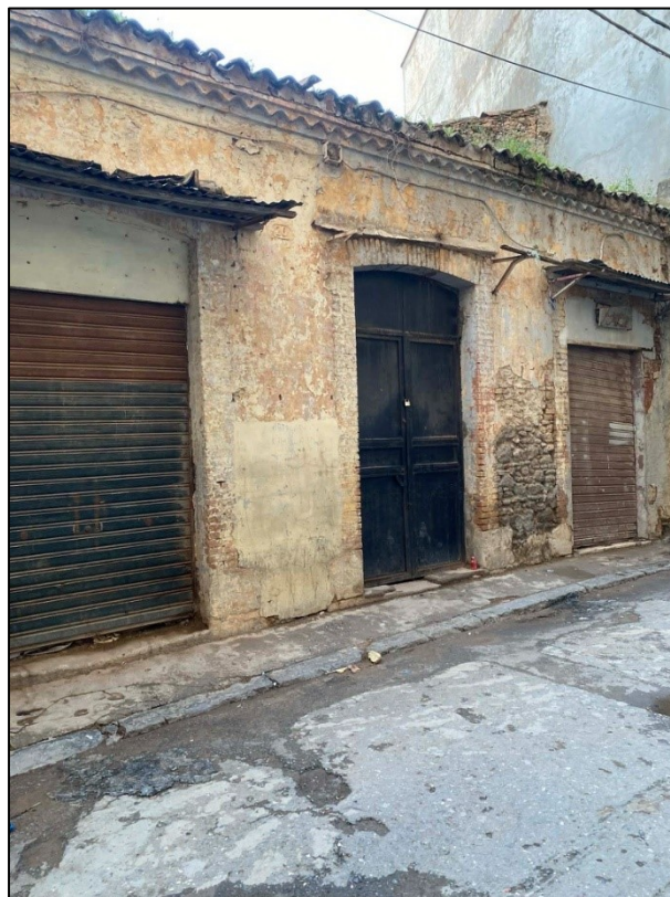
Figure I.26 : Entrée du foundouk Romana
