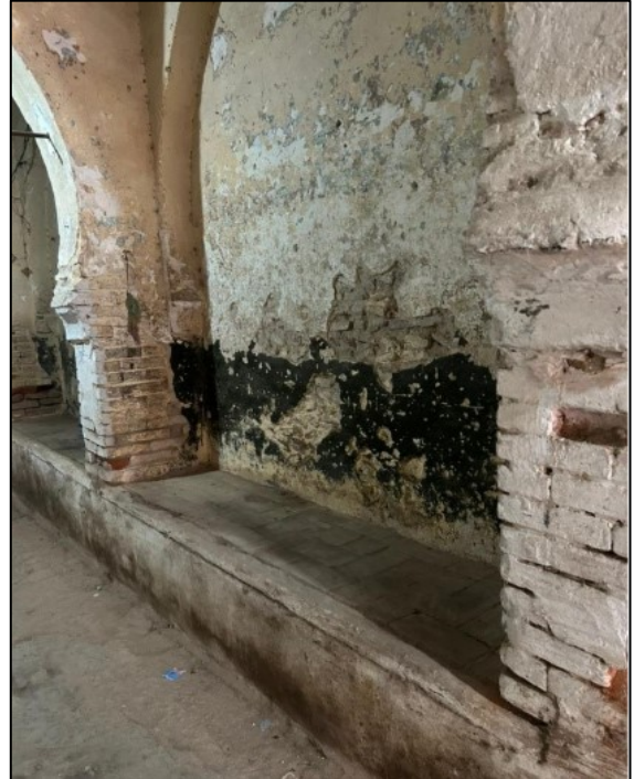
Figure II.19 : Mur en pierre
