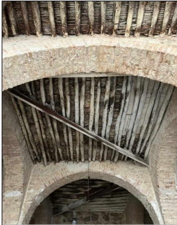
Figure II.22 : Elément métallique pour renforcer le plancher
