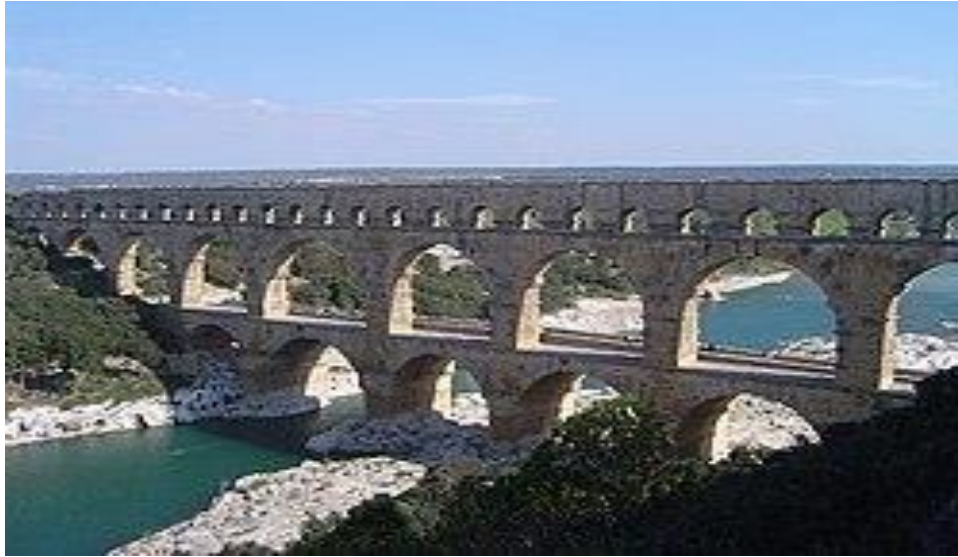
Figure II.11: Recalibrage des ouvrages d'art [36]
