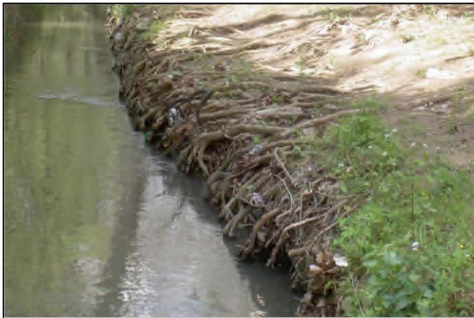
Figure II.10: Aménagement des berges de l'oued contre le glissement [29]
