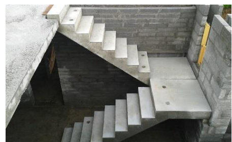
Figure 148: Escaliers préfabriqués sous forme de U
