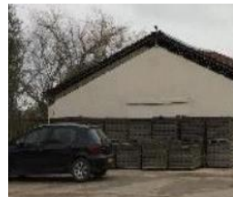
Figure 61: Charpente métallique des écuries
