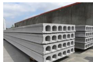
Figure 27: Dalle alvéolaire préfabriquée
