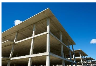
Figure 20: Ossature en béton préfabriqué
