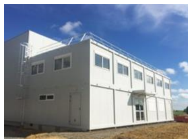
Figure 21: Système préfabriqué modulaire
