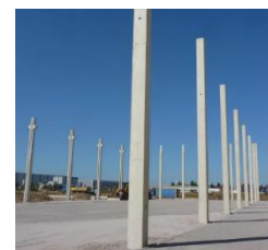
Figure 25: Poteaux préfabriqué en béton précontraint
