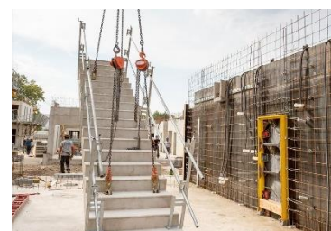
Figure 29: escaliers préfabriqués
