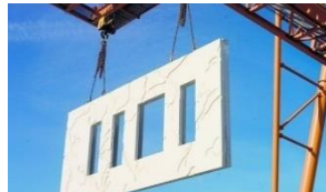
Figure 3: panneaux de façade en béton préfabriqués
