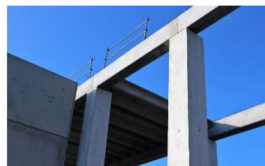
Figure 26: Poutre préfabriquée en béton
