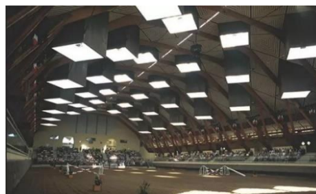
Figure 154: Manège d'entrainements avec des ouvertures zénithales
