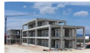
Figure 16: Portique en béton précontraint
