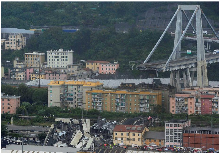
Figure I.4 : Effondrement du pont Morandi le 14 août 2018, à Gênes en Italie 1 .
