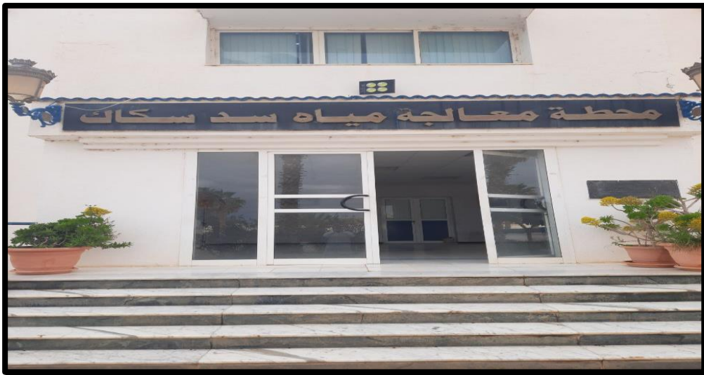
Figure .10 : Station de traitement des eaux potables Sekkak.
