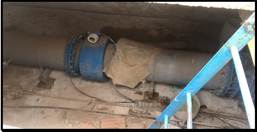
Figure .12 : Chambre des vannes.
