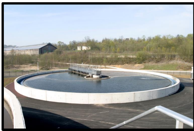
Figure.5 : Un bassin de clarification.
