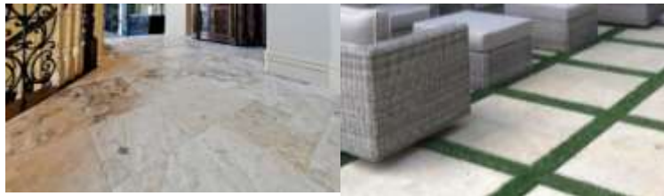
Photo 14 Revêtement du sol
