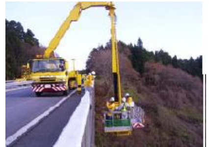
Photo.4-12 Inspection des ponts
