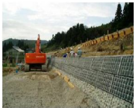
Photo.4-7 Protection des talus
