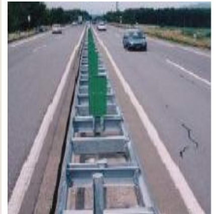
Fig.4-18 Glissière de sécurité médiane renforcée contre l'empiètement sur la voie opposée
