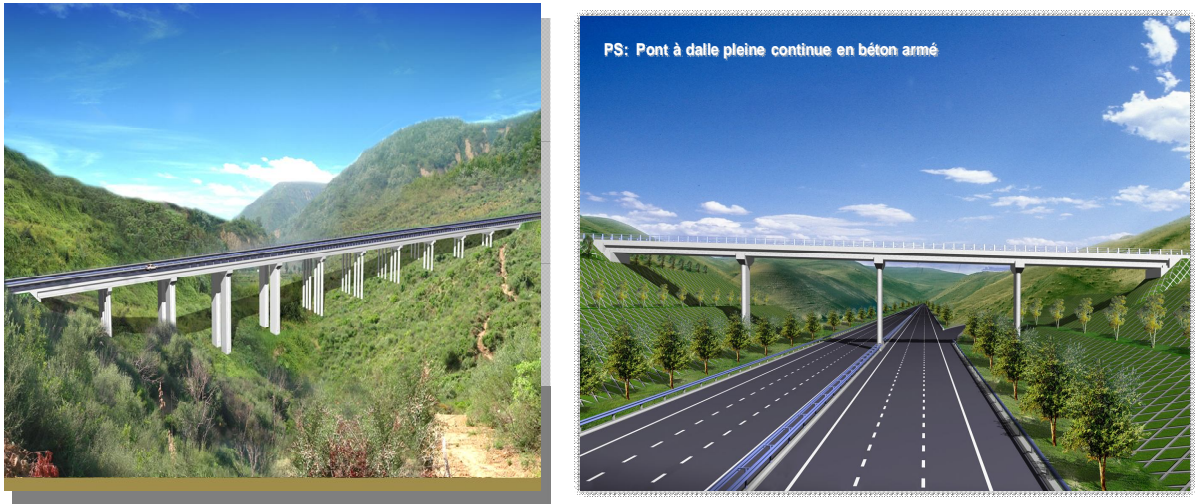
Photo.4-5 Protection de l'environnement et respect de l'harmonie de la nature (Viaduc et PS de Tlemcen) D'autre part, les études d'impact sur l'environnement du Parc d'El Kala qui présente une superficie de près de 80 000 hectares (800 Km 2 ), doivent être plus poussées et strictement contrôlés.
