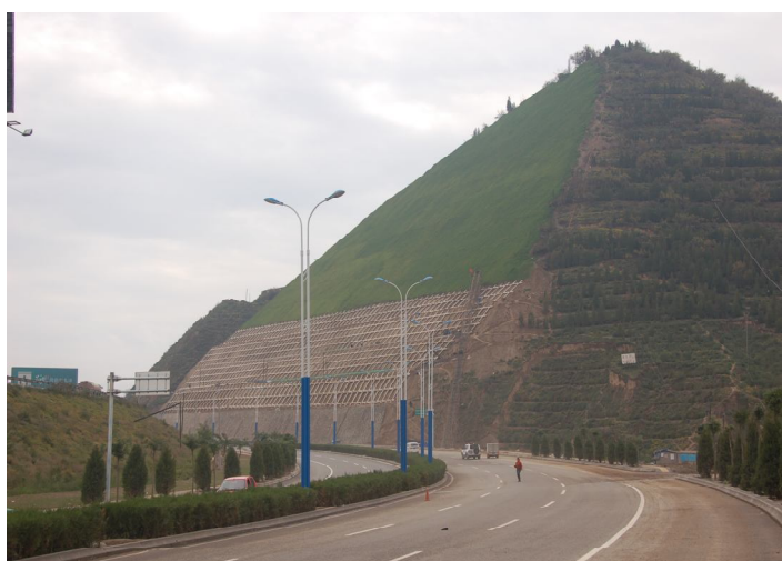
Photo 2-3 Engazonnement de talus
