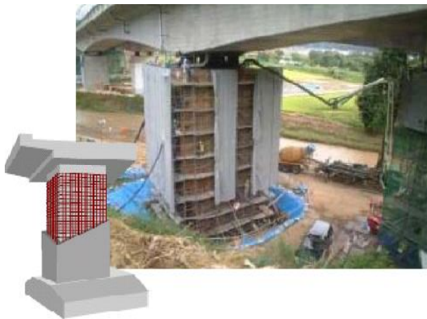
Photo.4-6 Renforcement contre les séismes
