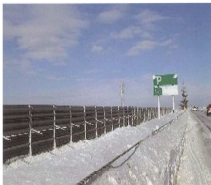
Photo.4-1 Barrières à neige
