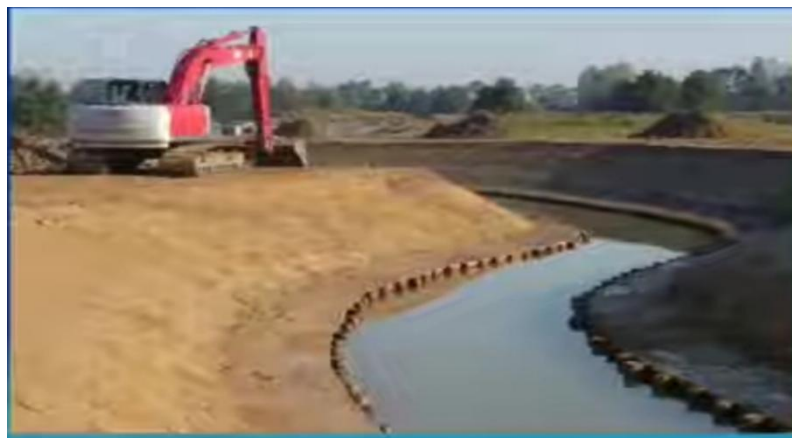
Figure 4.37 : Réalisation des canaux
