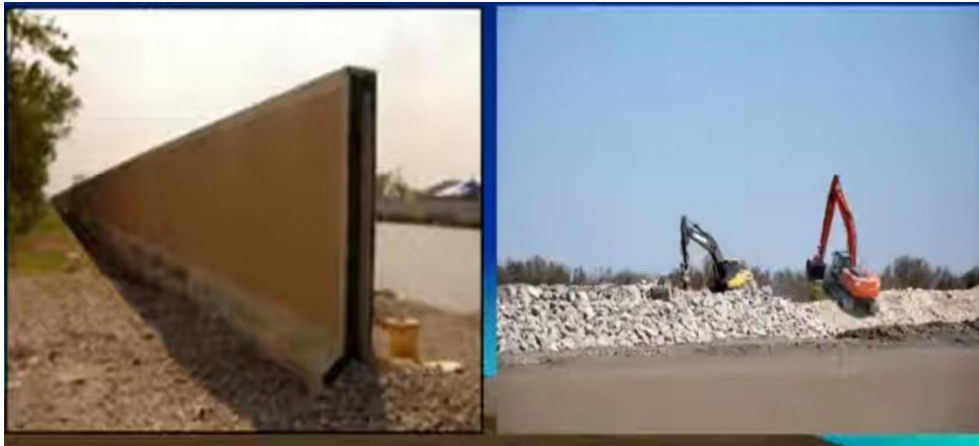
Figure 4.34 : Protection endiguement des oueds
