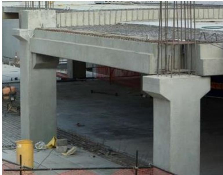
Figure II-5 : Assemblages par béton coulé en place [25].
