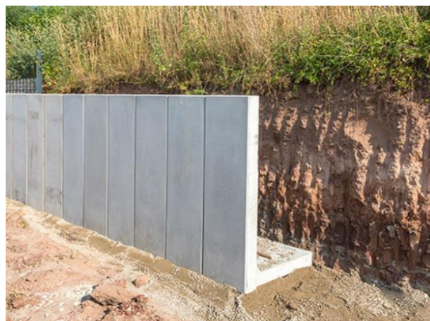
Figure I-15 : Murs de Soutènement [12].
