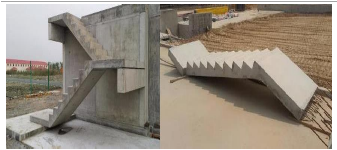
Figure II-12 : Mise en place et liaison d'un escalier préfabriqué en béton armé [32].
