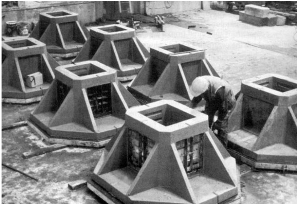
Figure III-55 : Fondation en alvéole entièrement préfabriquée [36].
