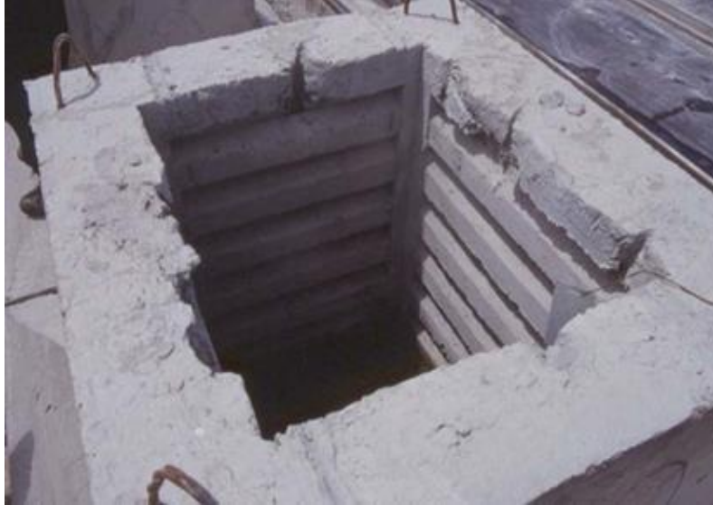
Figure III-57 : Alvéole préfabriquée avec Castellations pour ancrage renforcé [34].
