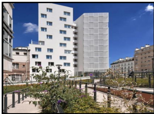
Figure 8 : Immeuble composite BigoniMurtmard. Source : https://archello.com/fr/project/social-housing-3 .
