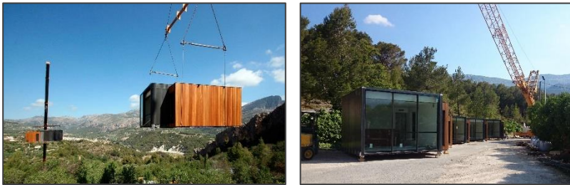
Figure47. La pose des cellules préfabriquées.
