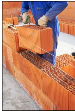
Figure174. Mur en brique en 15 cm.
