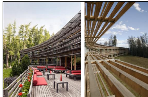
Figure64. Les façades de la station Vigilus.
