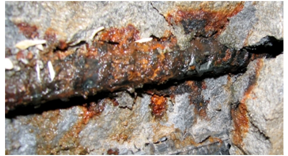
Figure80 : photo des de la corrosion des armatures de hôtel de ville source :auteur
