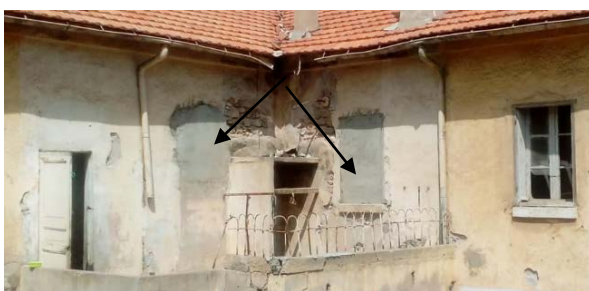
Figure 79: la fermeture de l'ouverture et la dégradation de l'enduit source : auteur
