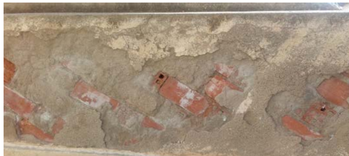
Figure82 : décapage superficelle de l'enduit : auteur
