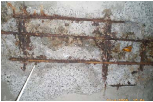
Figure80 : photo des de la corrosion des armatures de hôtel de ville source :auteur
