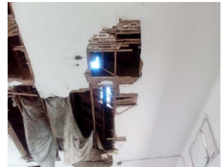
Figure78 : photo des des endommagement du : charpente en bois-les mur de séparation-les tuiles - de hôtel de ville source : auteur
