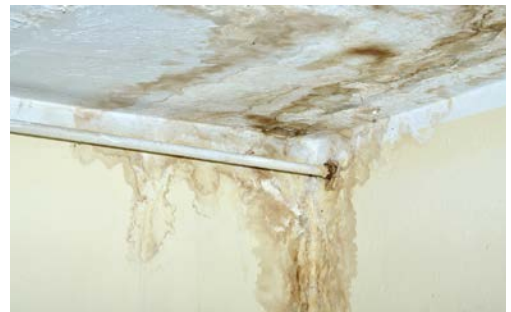
Figure81 : photo des de moisissure des espace intérieure de hôtel de ville source :auteur
