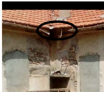
Figure78 : photo des des endommagement du : charpente en bois-les mur de séparation-les tuiles - de hôtel de ville source : auteur
