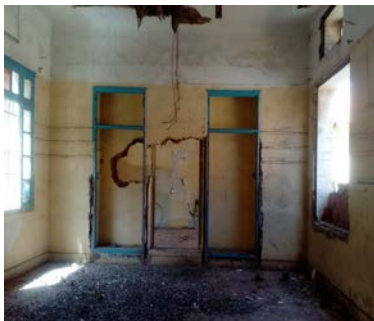
Figure78 : photo des des endommagement du : charpente en bois-les mur de séparation-les tuiles - de hôtel de ville source : auteur
