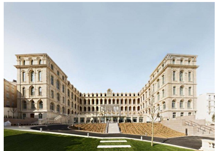
la reconversion en cours de l'Hôtel-Dieu de Marseille en hôtel Intercontinental de 194 clés
