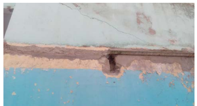
Figure 79: la fermeture de l'ouverture et la dégradation de l'enduit source : auteur
