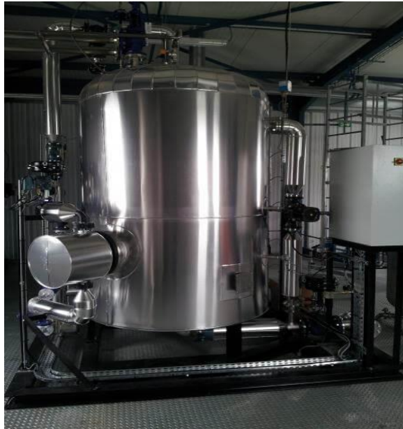
Figure 10: Echangeur thermique pour fabriquer les boissons[9]
