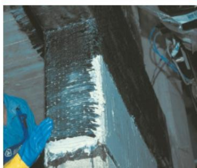
Renforcement d'un poteau et d'une poutre
