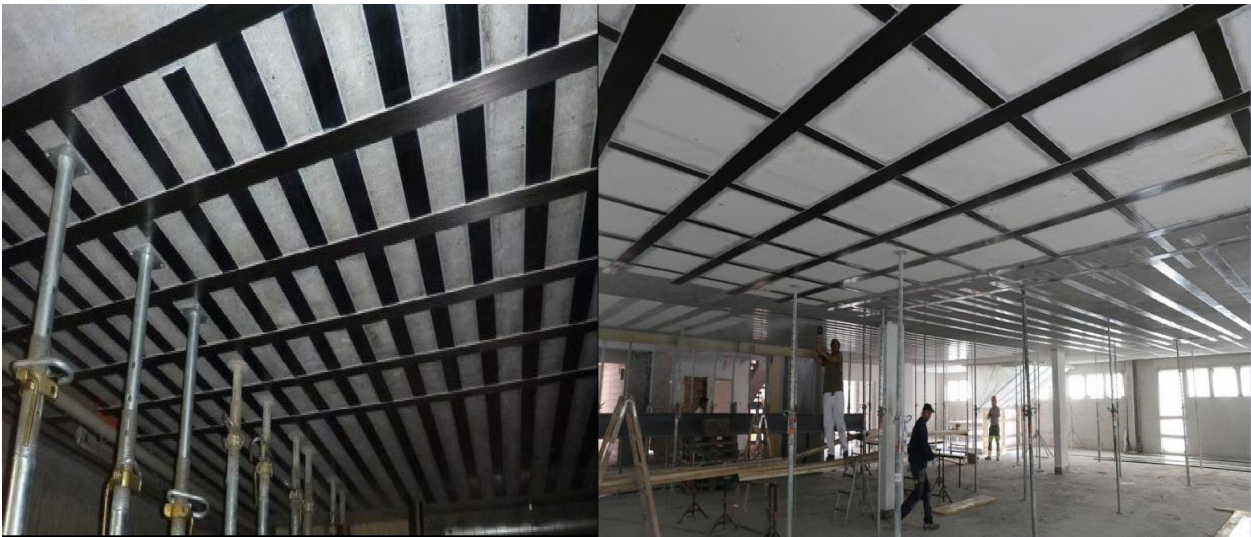
Figure 9 : Renforcement des dalles en béton par des bandes en CFRP
