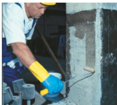
Application de MapeWrap Primer 1
