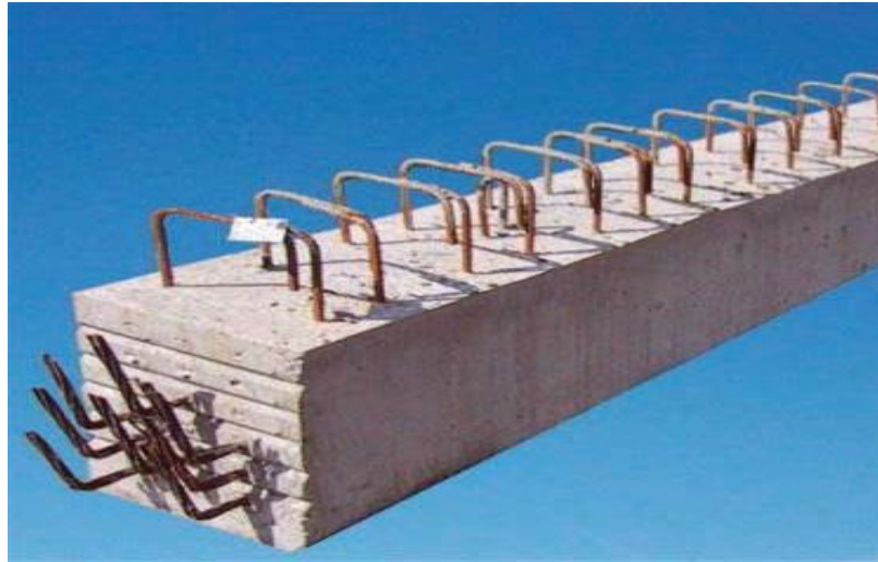
Figure10 : Béton armé, illustration de poutre armée
