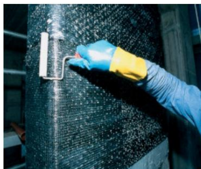
Application de la seconde passe de MapeWrap 31
