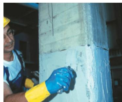
Ratissage éventuel avec MapeWrap 11 ou MapeWrap 12
