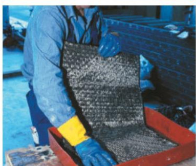
Imprégnation manuelle de MapeWrap C
