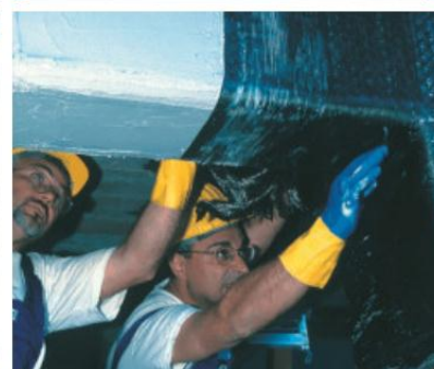
Renforcement d'un nœud poteau/poutre
