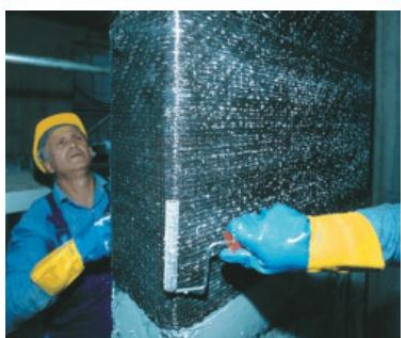
Application de la première passe de MapeWrap 31
