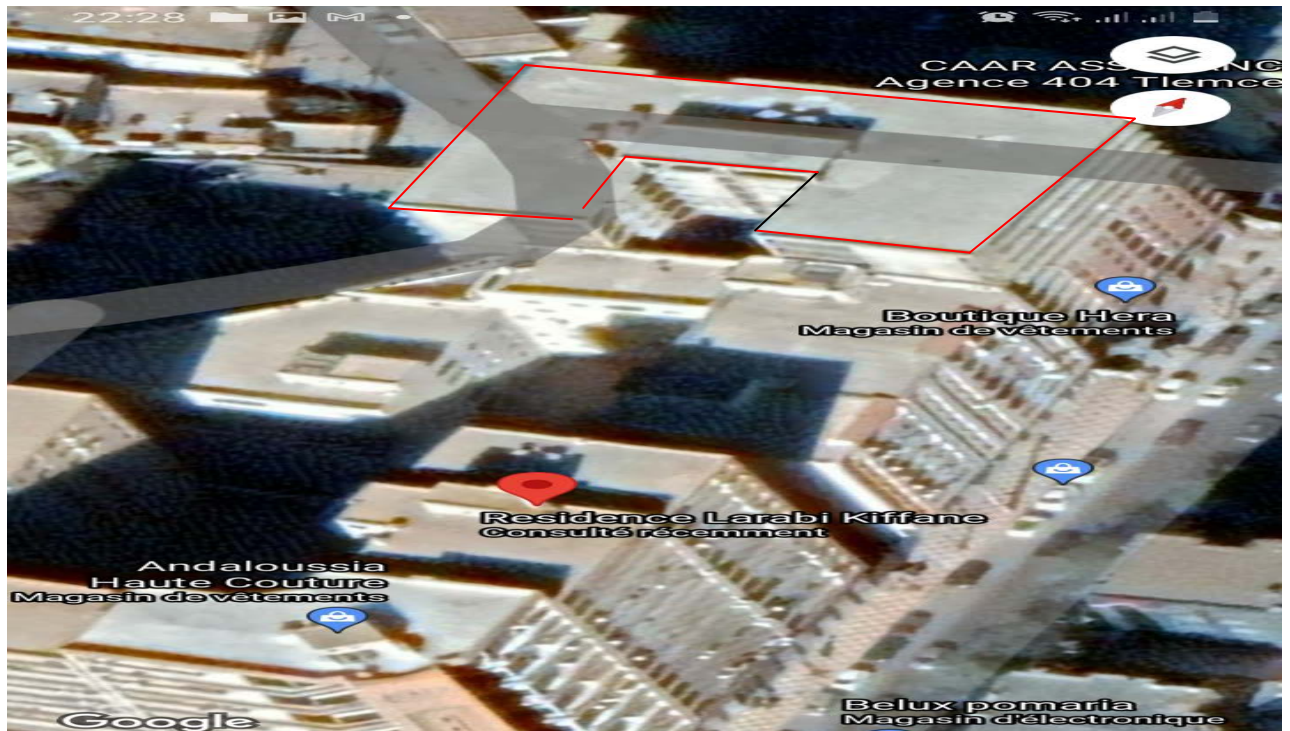
Figure I-1: Vue panoramique de l'immeuble (Google Maps).
