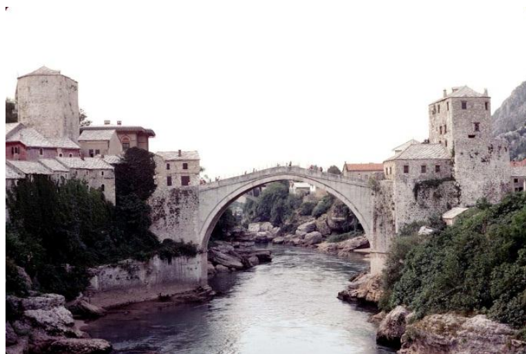
Figure 2.6. Vieux Pont de Mostar, Construit entre 1566 et 1567 [11]
