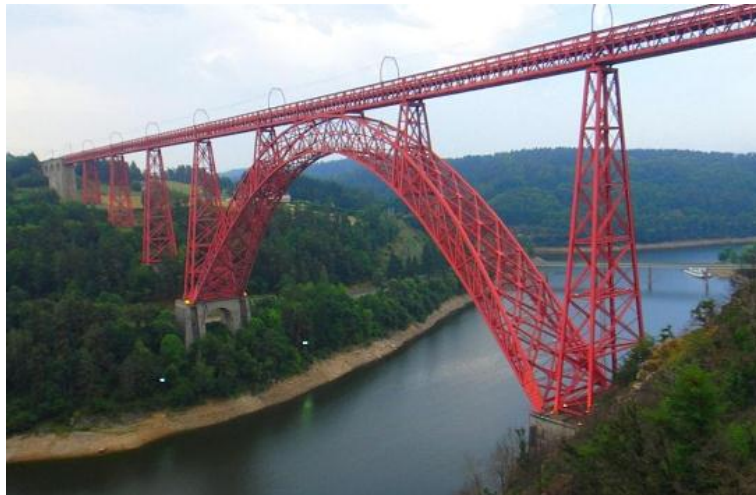
Figure 2.7. Viaduc de Garabit, France, 1884 [12]
