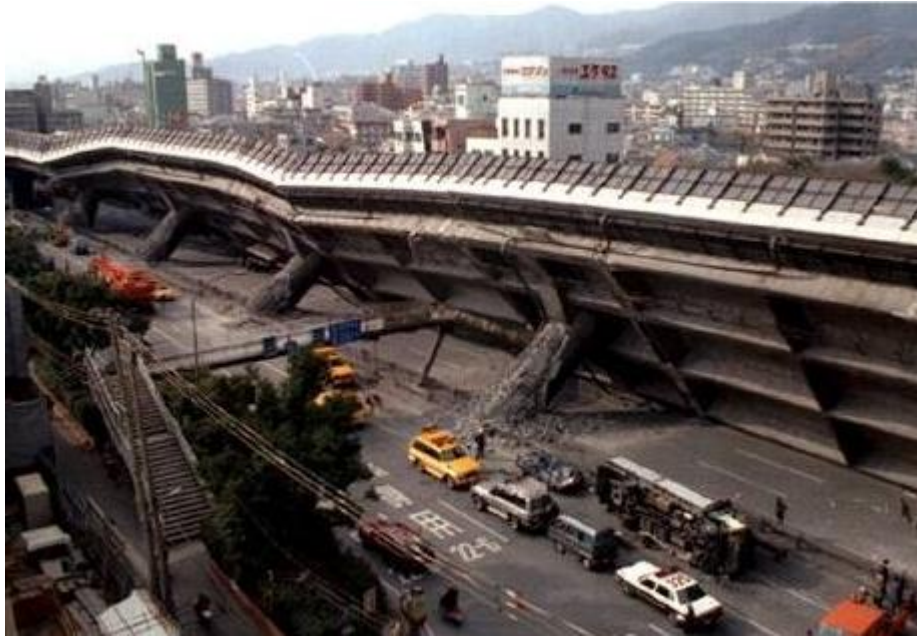
Figure 3.4. Pont détruit par un séisme, Kobe, janvier 1995
