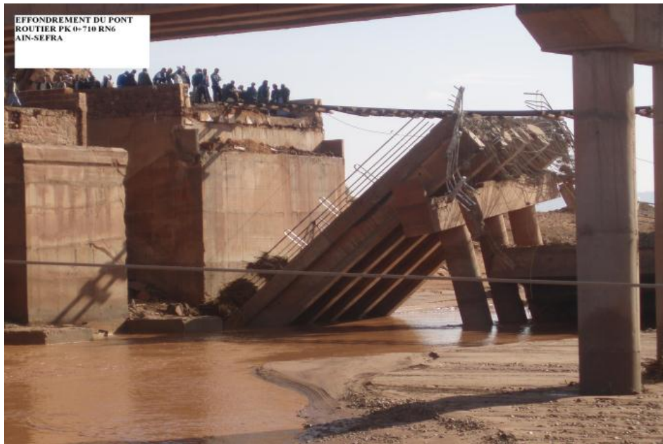
Photo 3.2. Effondrement du pont sur oued Barika à Ain Sefra, Algérie [42]
