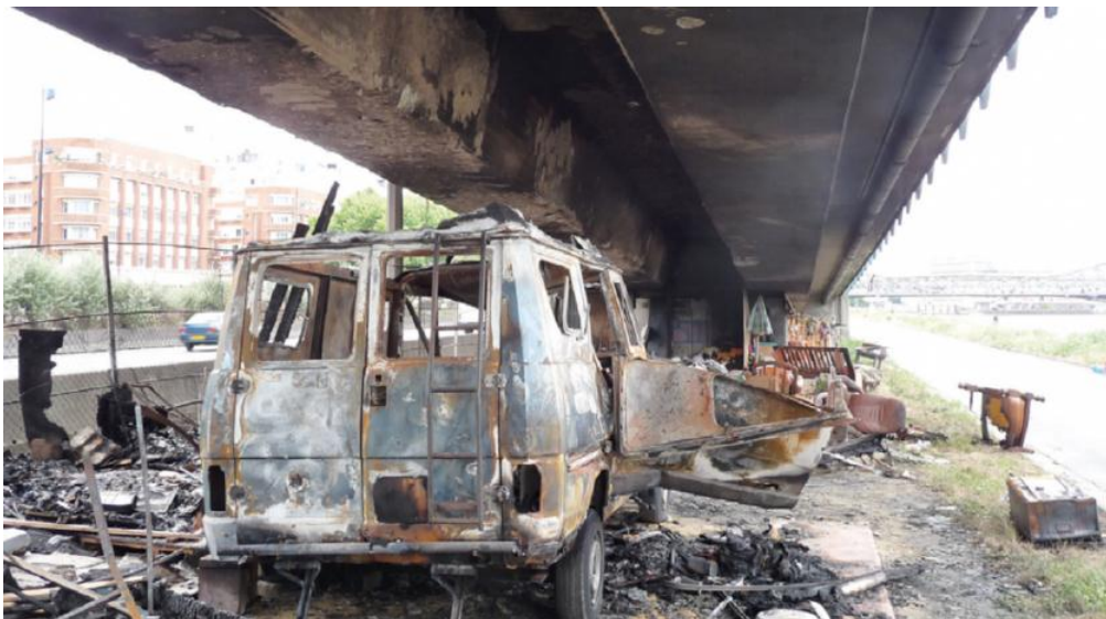
Figure 3.6. Résistance à l'incendie d'un pont routier [55]
