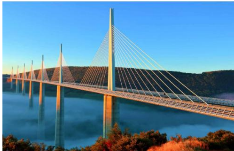
Figure 2.9. Viaduc de Millau, France, 2004 [14]
