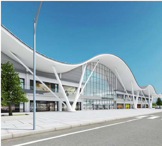
Figure 115. Toiture ondulée (courbée)
