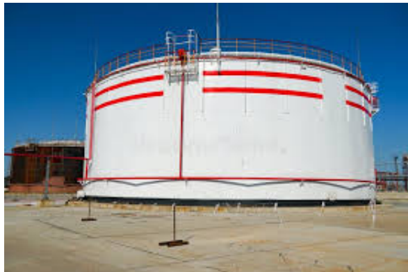
FIGURE 2.12 – Réservoir de stockage d'eau [19]
