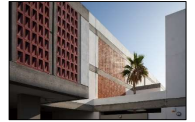
Figure 23 Façades en briques
