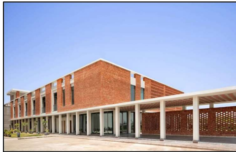
Figure 123 Façade en brique
